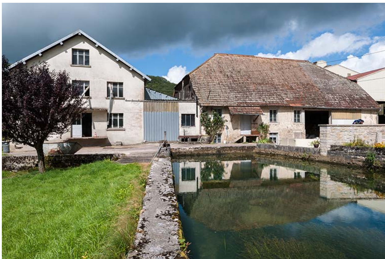
Le moulin depuis le bief d'aménée.
