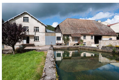
Le moulin depuis le bief d'amenée. Phot. Jérôme Mongreville IVR43_20142501313NUC4A
