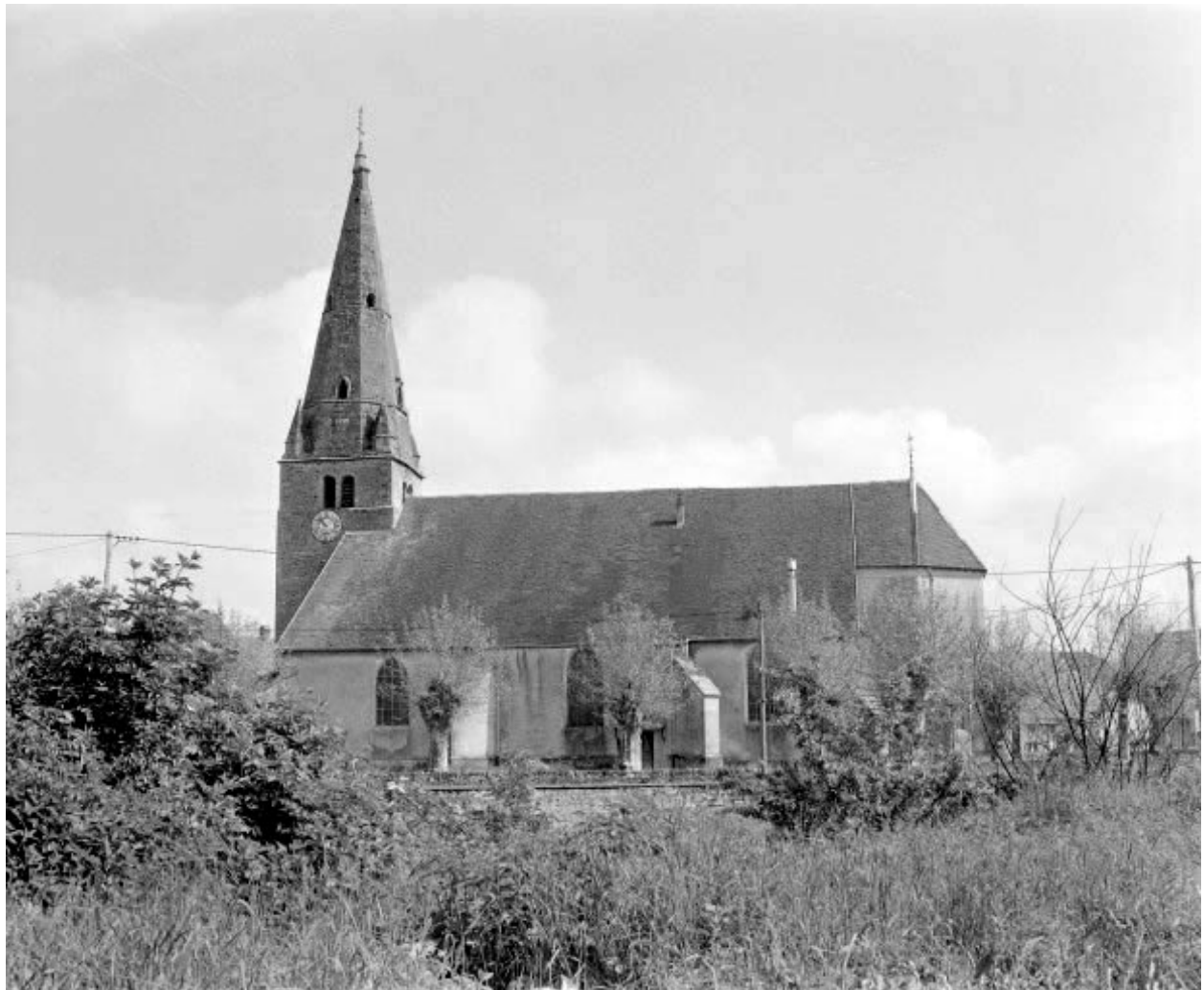
Façade latérale sud.
