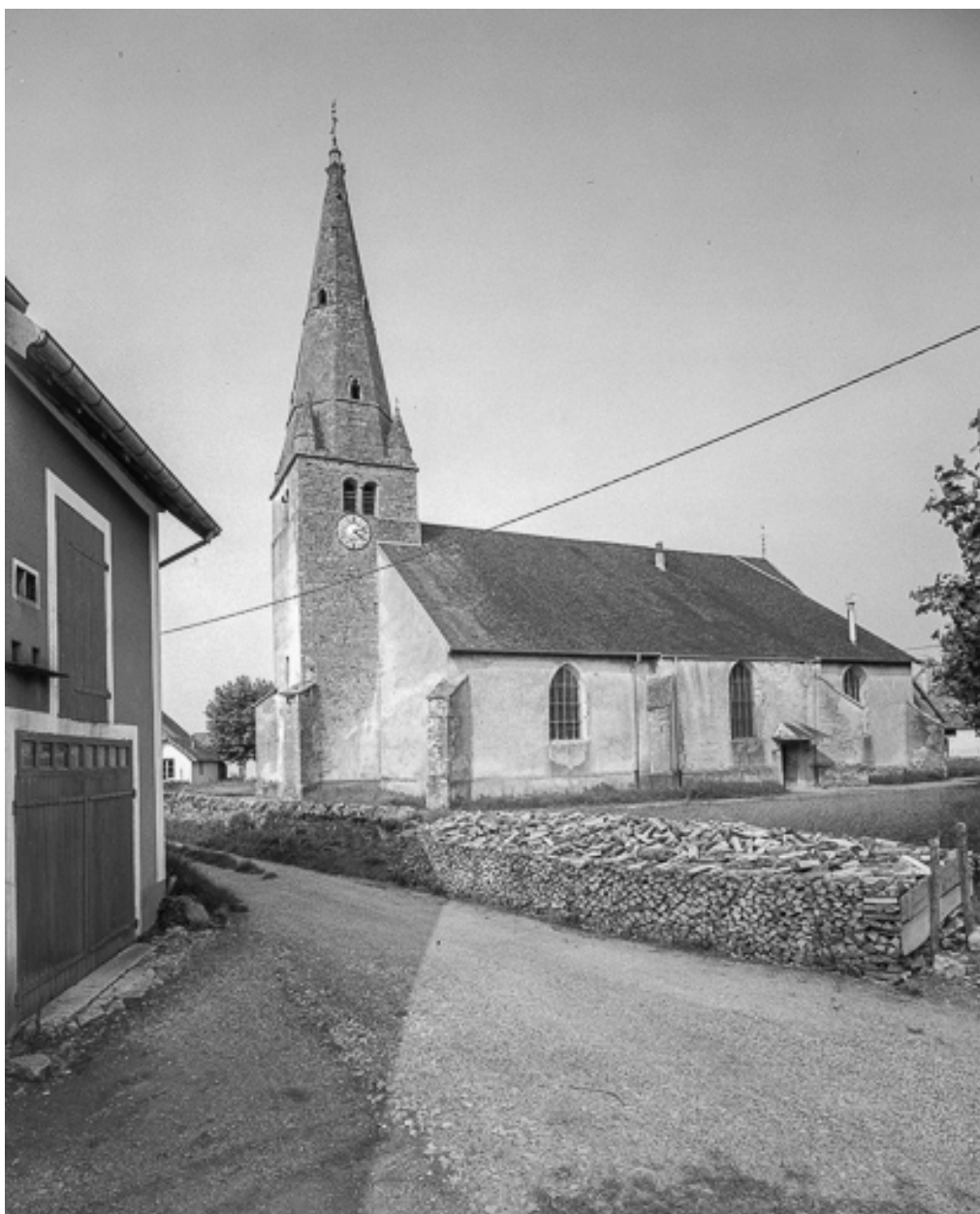
Façade latérale sud.
