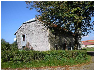
Pignon sud-ouest vu de trois quarts.
