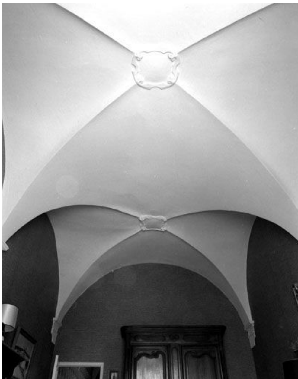
La voûte de la chapelle.
