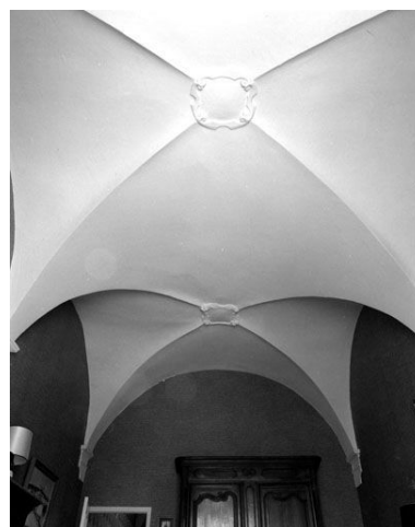
La voûte de la chapelle. Phot. Yves Sancey IVR43_19843900402X
