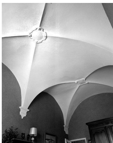
La voûte de la chapelle. Phot. Yves Sancey IVR43_19843900403X
