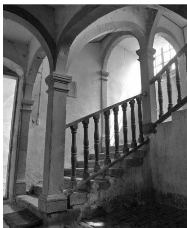
Escalier intérieur : première volée. Phot. Yves Sancey IVR43_19843900396X
