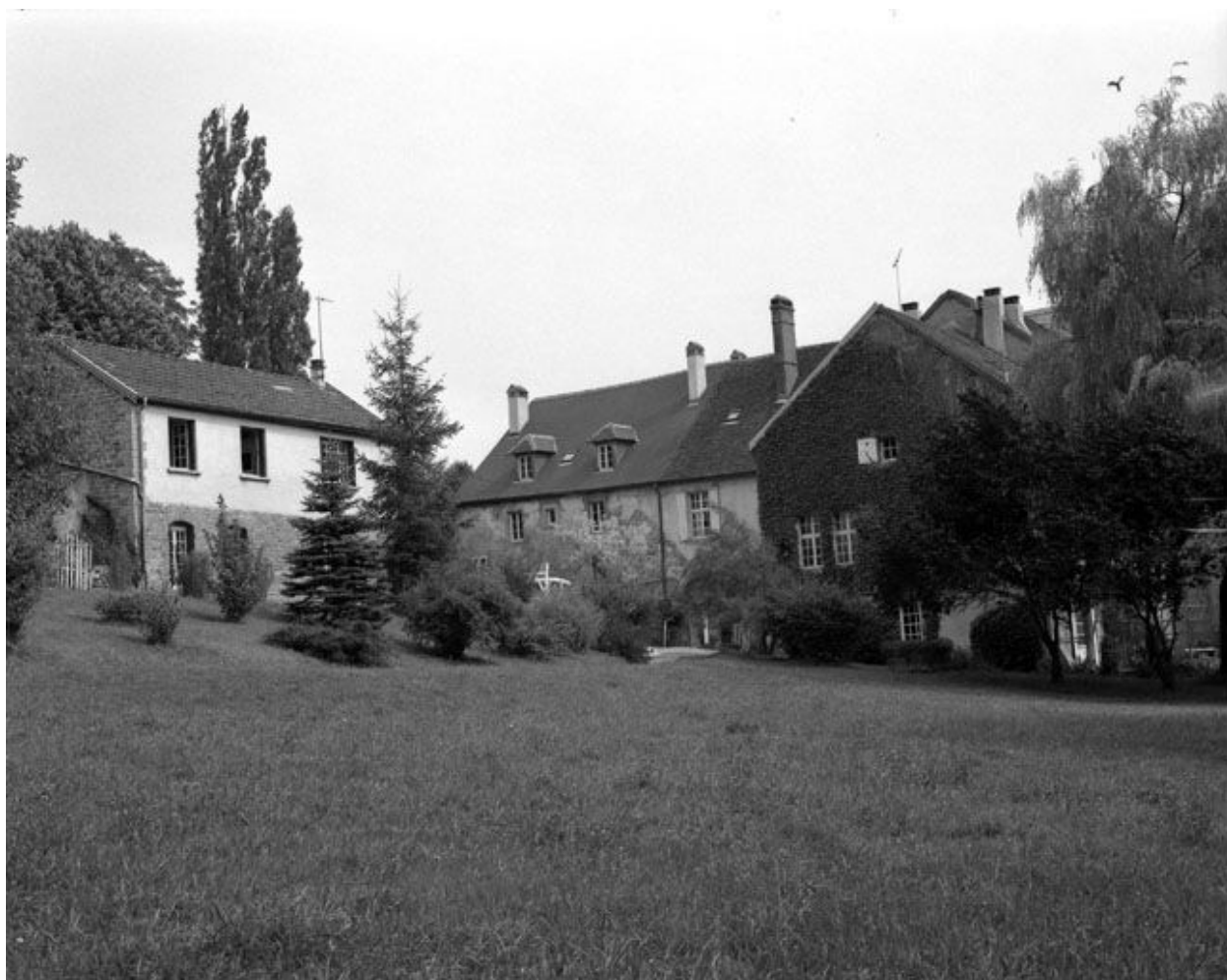
Façade postérieure : vue de trois quarts gauche.
