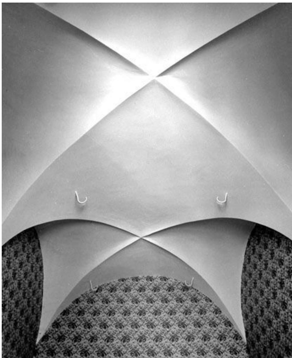
La voûte du poêle.
