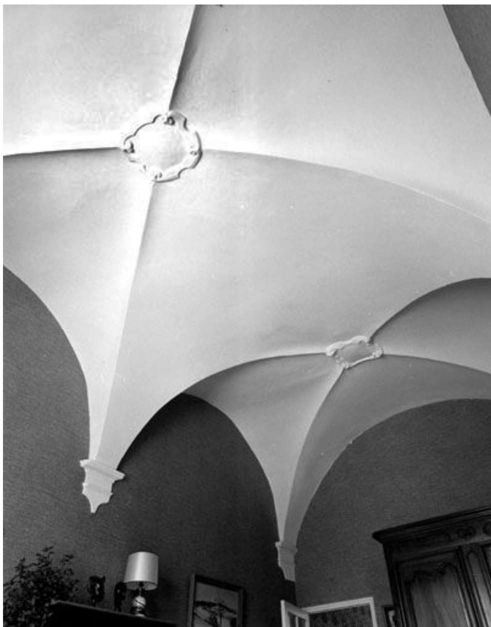
La voûte de la chapelle.
