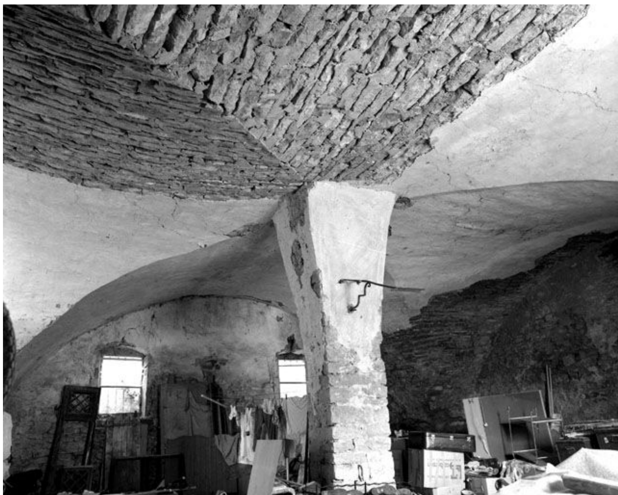
Pièce voûtée au rez-de-chaussée : la voûte.
