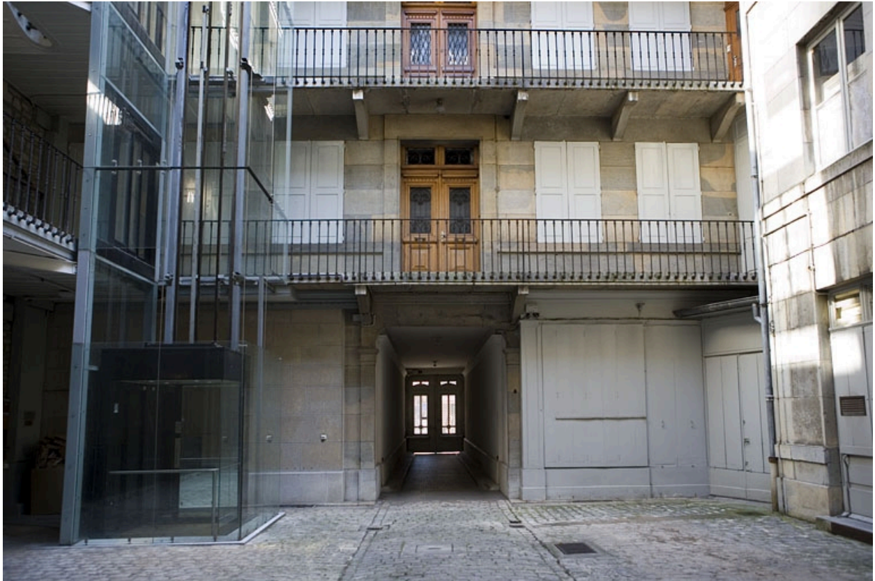
Vue du logis en fond de cour avec son passage cocher.
