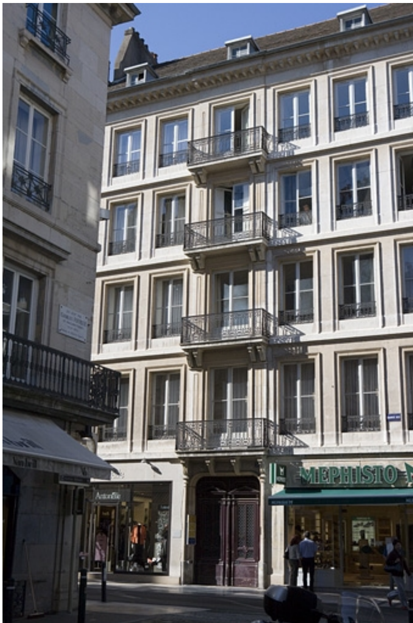
Vue d'ensemble rapprochée de l'édifice depuis la rue.
