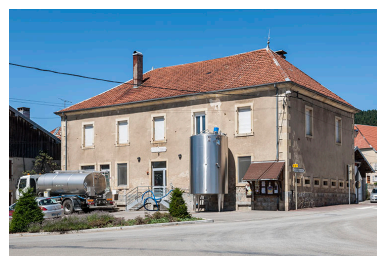
Vue de trois quarts droite. Phot. Jérôme Mongreville IVR43_20152501656NUC4A
