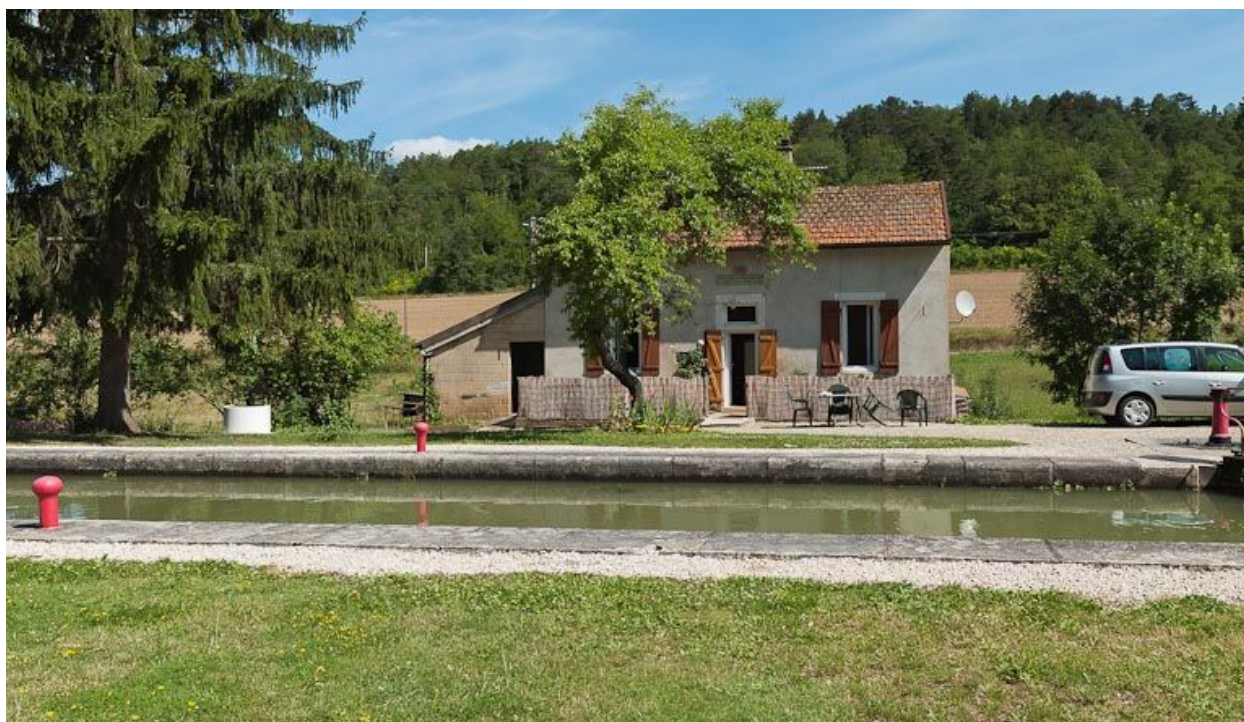
Vue de face de la maison éclusière.
