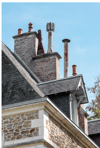
Couverture en ardoise, lucarnes et cheminées. Phot. Pierre-Marie Barbe-Richaud IVR26_20195800044NUC4A
