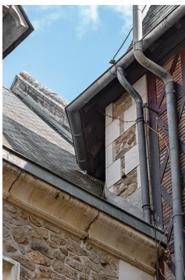
Association du granite, du calcaire, du bois, de la brique et de l'ardoise. Phot. Pierre-Marie Barbe-Richaud IVR26_20195800046NUC4A
