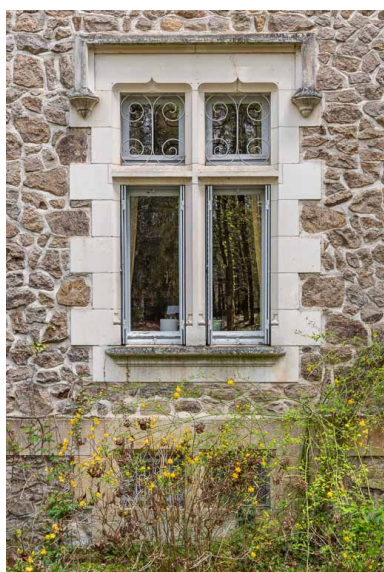
Croisée couverte d'un linteau décoré d'accolades (baie du rez-de- chaussée de la façade sud-ouest). Phot. Pierre-Marie Barbe-Richaud IVR26_20195800045NUC4A
