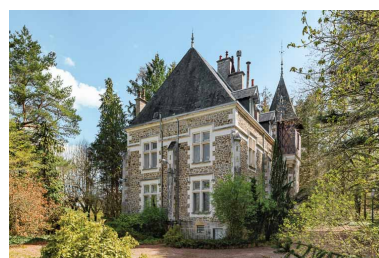
Façade nord-ouest. Phot. Pierre-Marie Barbe-Richaud IVR26_20195800043NUC4A
