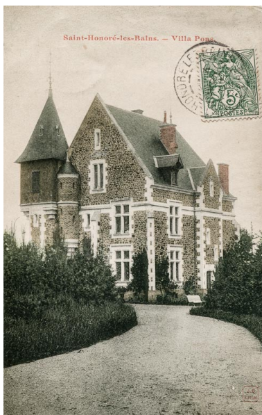
Élévation extérieure de la villa, moins de dix ans après sa construction. Autr. auteur inconnu IVR26_20195800114NUC2A
