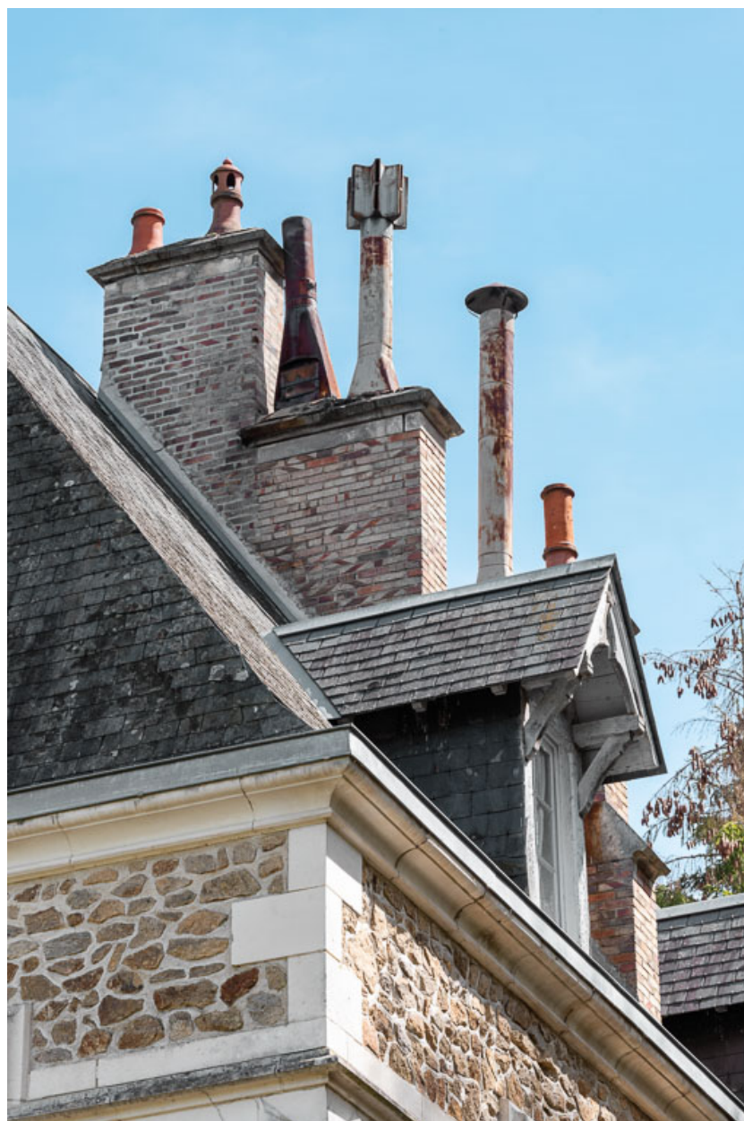
Couverture en ardoise, lucarnes et cheminées.
