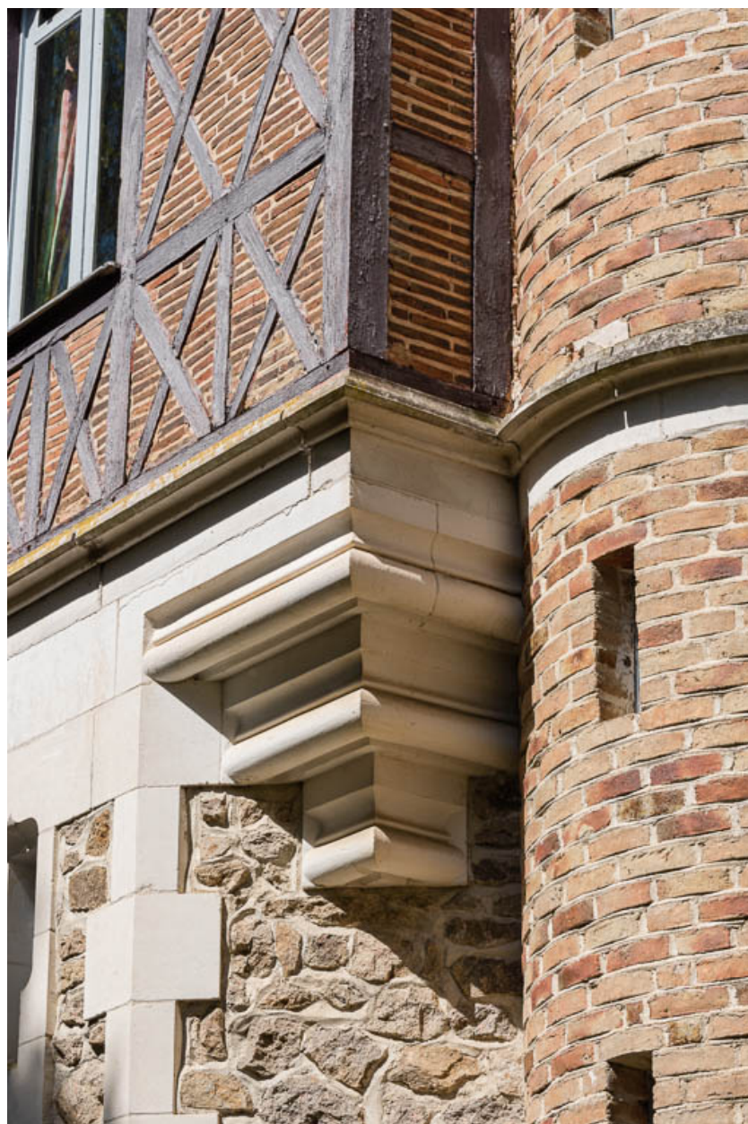
Culot de la tour d'angle supportant le troisième niveau en bois et brique.
