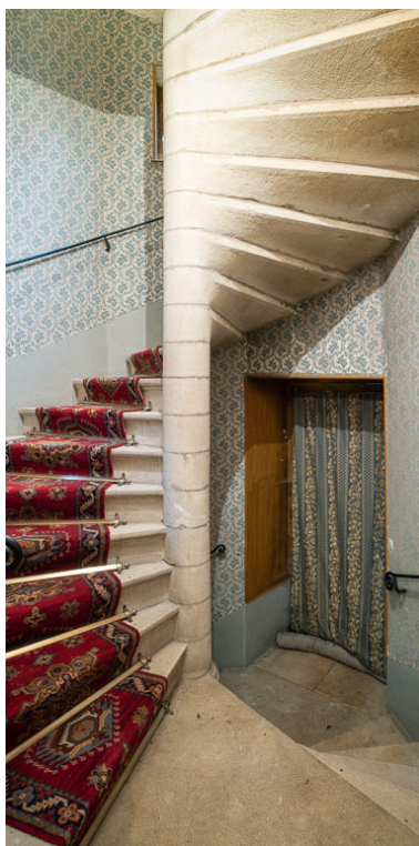
Escalier de l'entrée sud-ouest. Phot. Pierre-Marie Barbe-Richaud IVR26_20195800030NUC4A
