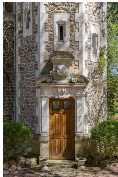
Porte d'entrée encadrée par deux pilastres et surmontée d'un fronton brisé à volutes supérieures rentrantes et d'un édicule à fronton cintré. Phot. Pierre-Marie Barbe-Richaud IVR26_20195800041NUC4A
