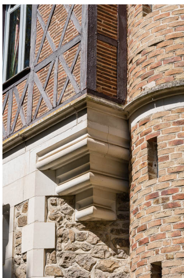
Culot de la tour d'angle supportant le troisième niveau en bois et brique. Phot. Pierre-Marie Barbe-Richaud IVR26_20195800039NUC4A
