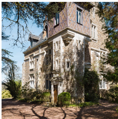
Tour d'angle de plan octogonal (aux deux premiers niveaux) et carré (au troisième niveau) contenant l'escalier en vis. Phot. Pierre-Marie Barbe-Richaud IVR26_20195800040NUC4A
