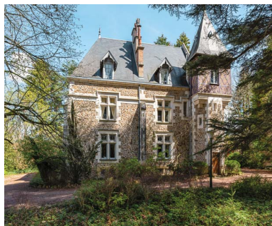
Façade sud-ouest. Phot. Pierre-Marie Barbe-Richaud IVR26_20195800042NUC4AQ
