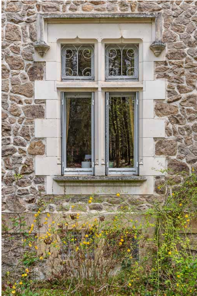
Croisée couverte d'un linteau décoré d'accolades (baie du rez-de-chaussée de la façade sud-ouest).
