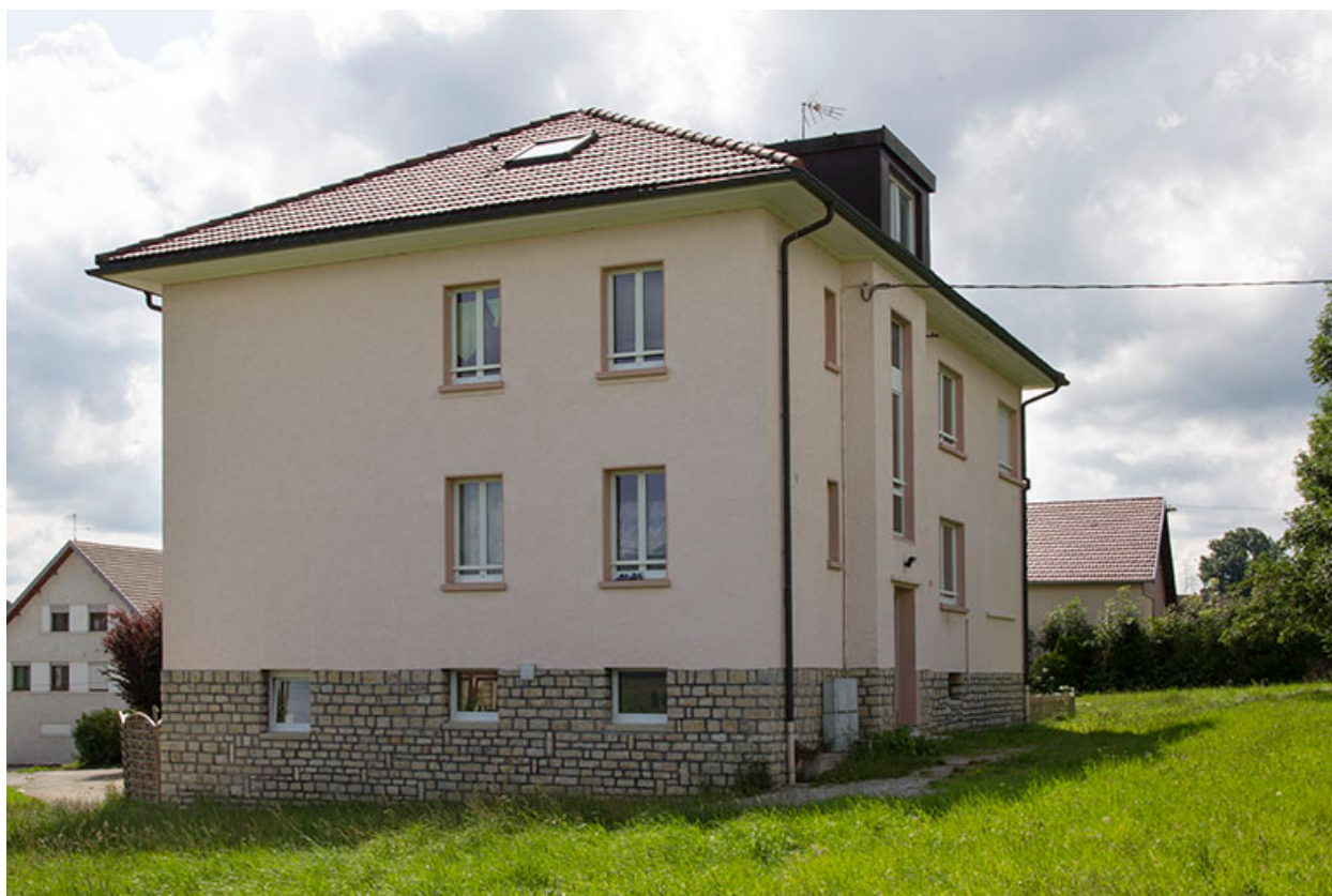
Façades latérale droite et postérieure.
