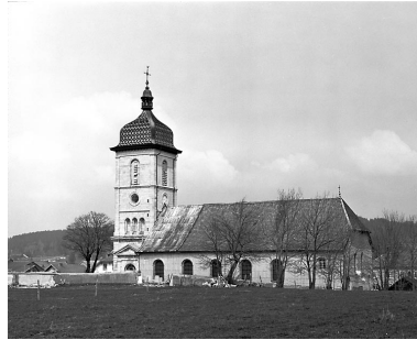
Vue de la façade sud. Phot. Yves Sancey IVR43_19812500066X
