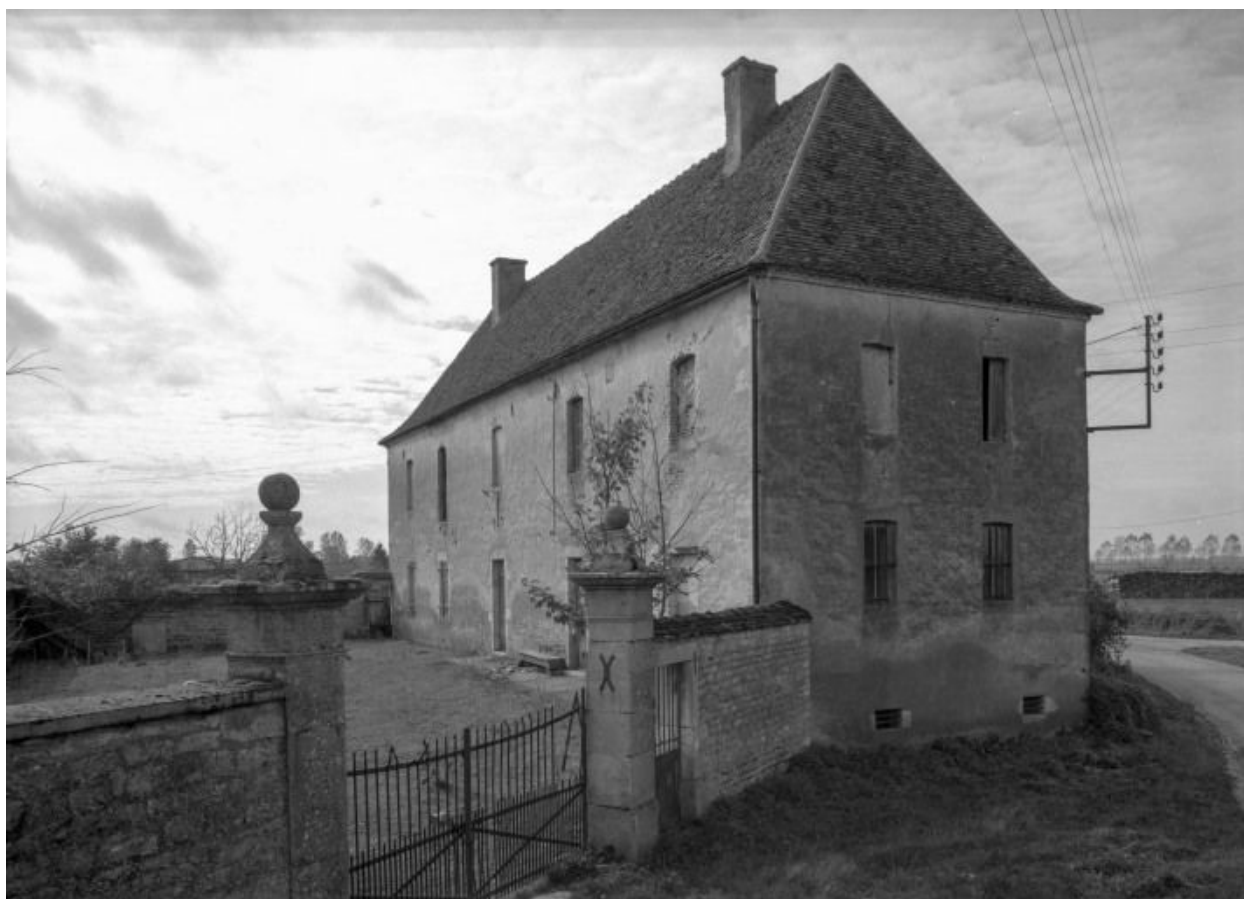
Portail et bâtiment d'habitation.
