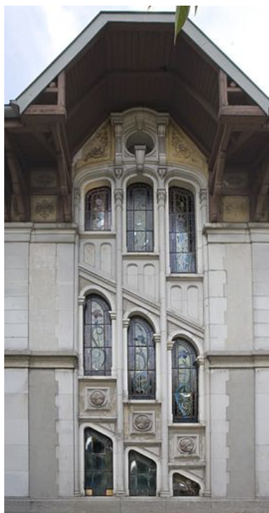
Vue d'ensemble, depuis l'extérieur. Phot. Yves Sancey IVR43_20093900174NUC2A
