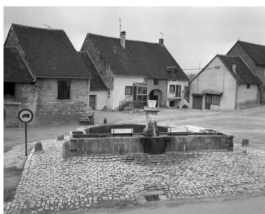
Fontaine-lavoir située au lieudit Savagna. Phot. Jérôme Mongreville IVR43_19853900144X
