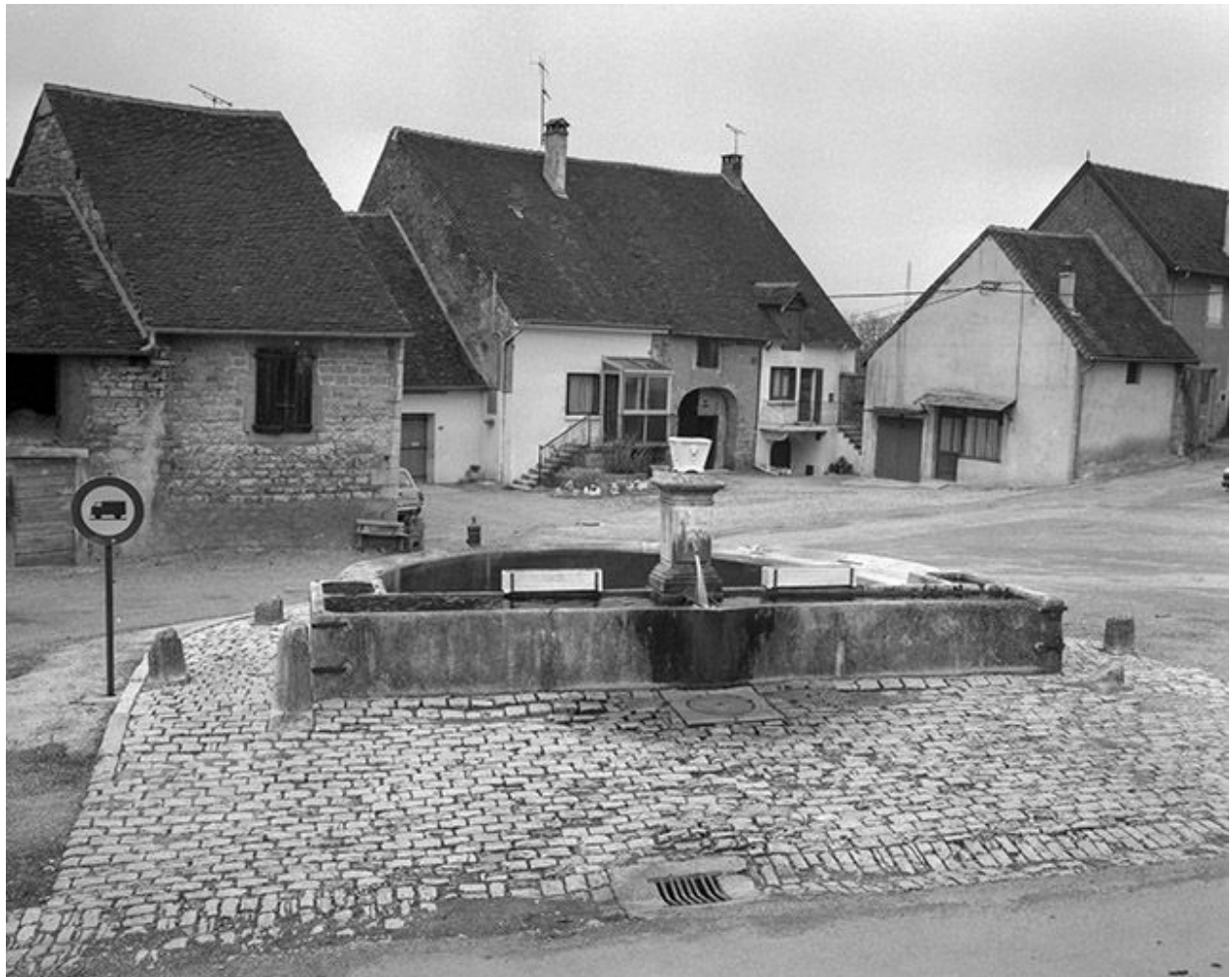
Fontaine-lavoir située au lieudit Savagna.
