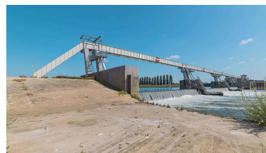
Le barrage d'Ormes vu depuis la pile ovale reliant ses deux parties. Phot. Thierry Kuntz IVR26_20217100402NUC4A
