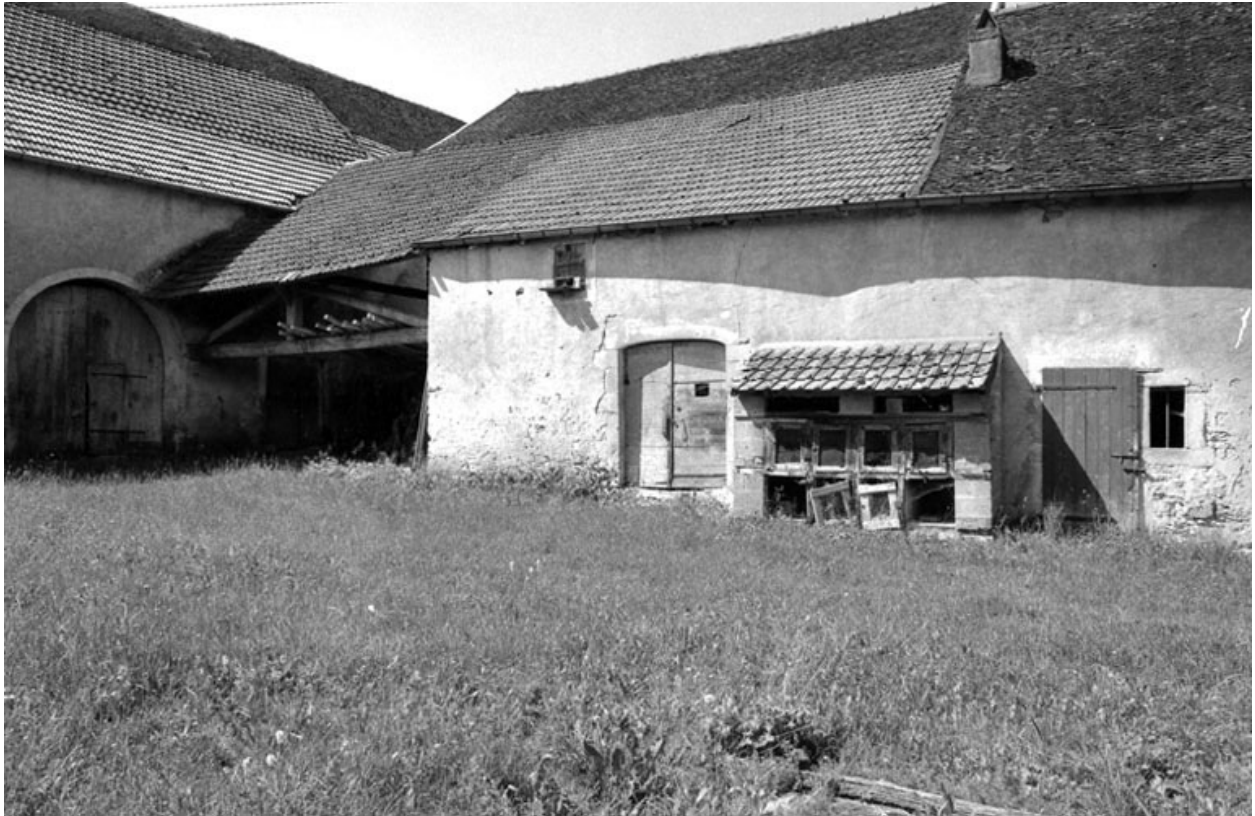
Détail : dépendances à droite dans la cour.
