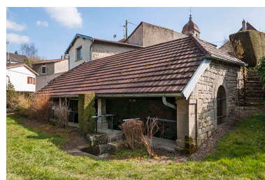
Vue d'ensemble. Phot. Jérôme Mongreville IVR43_20167000492NUC4A
