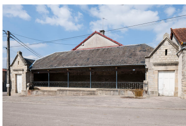
Vue d'ensemble. Phot. Jérôme Mongreville IVR43_20167000464NUC4A
