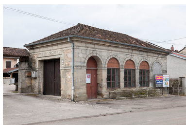
Vue d'ensemble. Phot. Jérôme Mongreville IVR43_20167000510NUC4A
