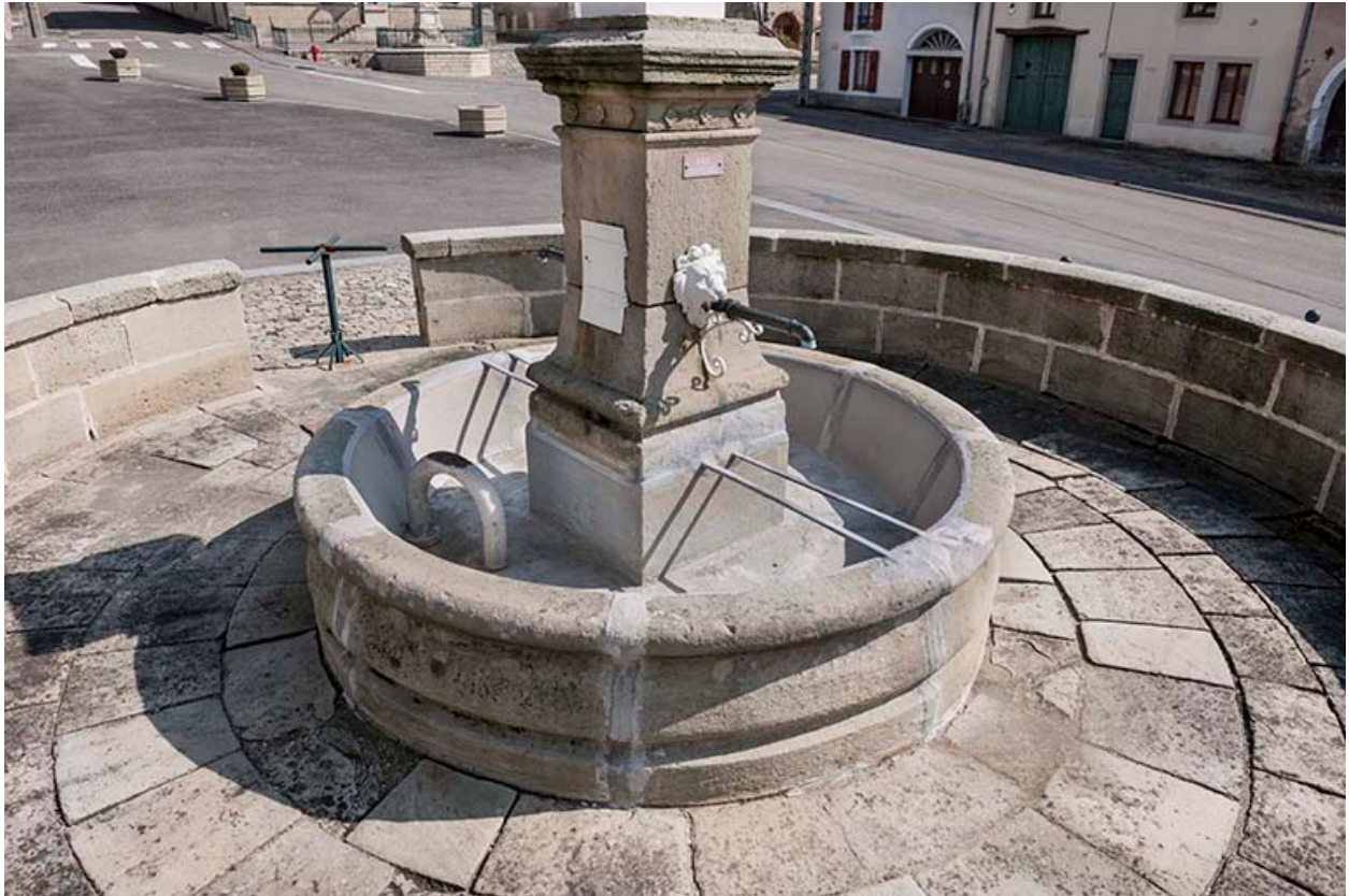
Intérieur de la fontaine.
