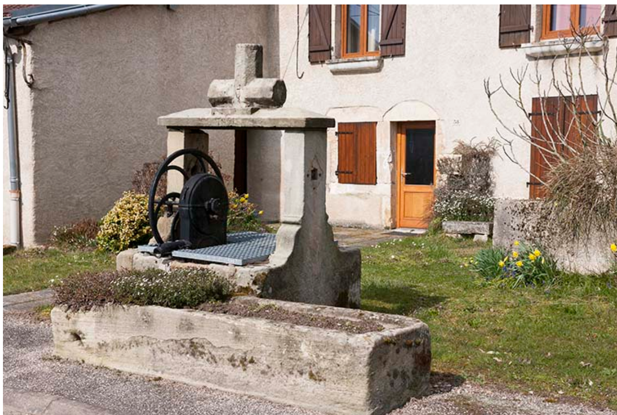
Puits situé rue Antoine Lumière.
