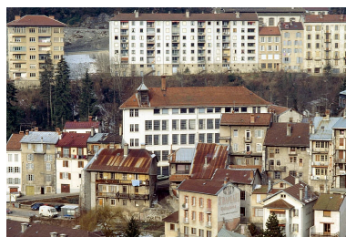
Vue d'ensemble depuis l'est. Phot. Laurent Poupard IVR43_19923901385ZA
