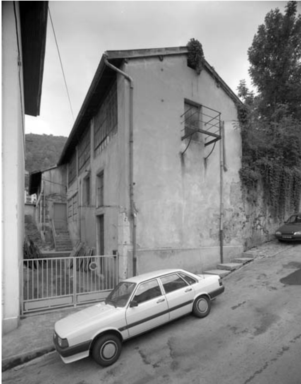
Entrepôts industriels (ancienne usine Genoud).
