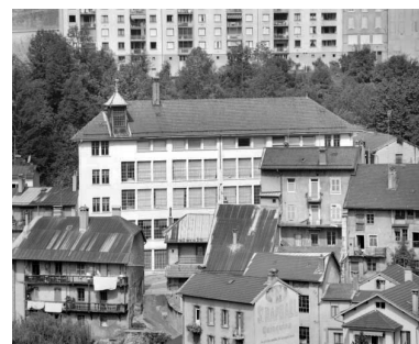
Façade antérieure. Phot. Jérôme Mongreville IVR43_19923900695X
