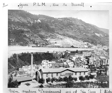
Usine moderne Dequinand qui est Sqs Sans l'indus Vue d'ensemble depuis le sud. Phot. , Phot. E. Mandrillon IVR43_19923900028X
