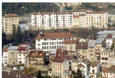
Vue d'ensemble depuis l'est. Phot. Laurent Poupard IVR43_19923901386ZA
