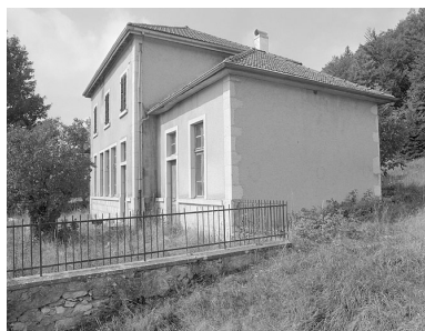
Façade antérieure et préau. Phot. Jérôme Mongreville IVR43_19963901289X
