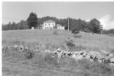
Vue de situation. Phot. Jérôme Mongreville IVR43_19963901285X
