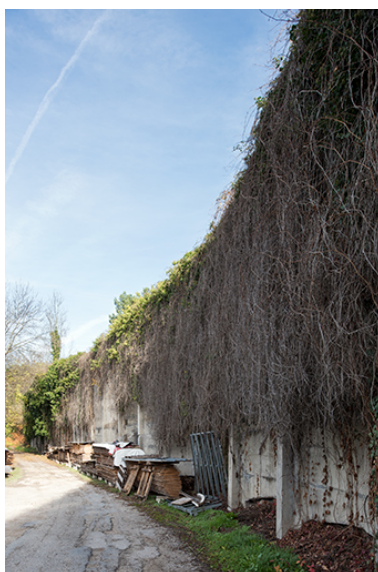
Mur de soutènement, depuis le sud. Phot. Nicolas Waltefaugle
