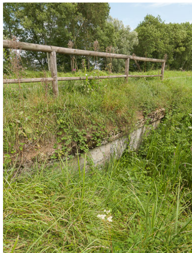
Vue de l'aqueduc.
