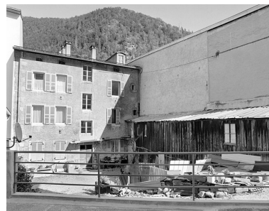
Elévation postérieure. Phot. Yves Sancey IVR43_20033900412X
