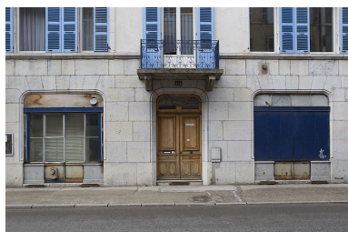
Rez-de-chaussée. Phot. Yves Sancey IVR43_20103900426NUC2A
