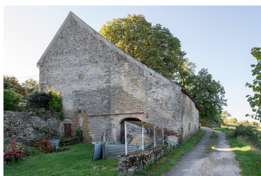
La ferme et la bergerie. Phot. Nicolas Waltefaugle IVR26_20258900216NUC4A
