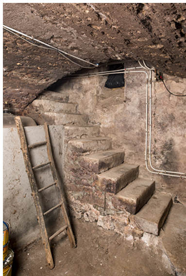
Le premier cellier et l'escalier d'accès intérieur à la maison. Phot. Nicolas Waltefaugle IVR26_20268900012NUC4A
