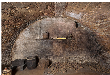
Le fond du premier cellier. Phot. Nicolas Waltefaugle IVR26_20268900009NUC4A
