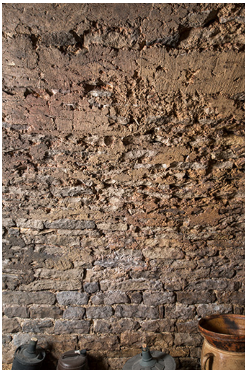
Détail du parement du premier cellier.
