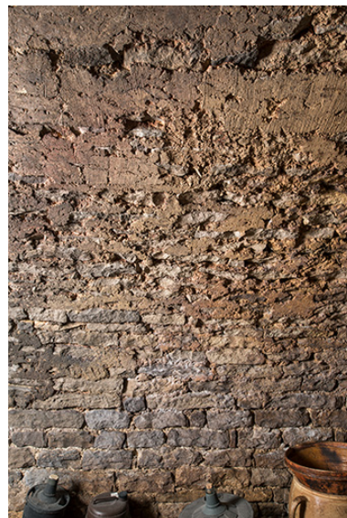
Détail du parement du premier cellier. Phot. Nicolas Waltefaugle IVR26_20268900010NUC4A
