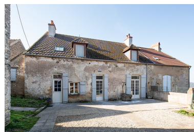
La façade de la maison depuis la cour. Phot. Nicolas Waltefaugle IVR26_20268900006NUC4A
