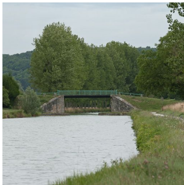
Vue du pont. Phot. Pierre-Marie Barbe-Richaud IVR26_20118900353NUC2AQ
