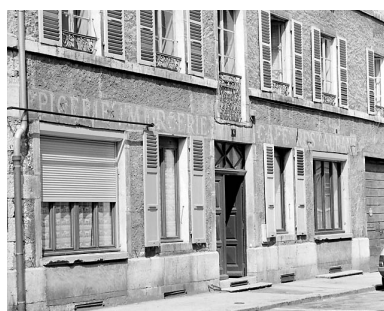
Baies de l'élévation antérieure. Phot. Yves Sancey IVR43_20033900126X
