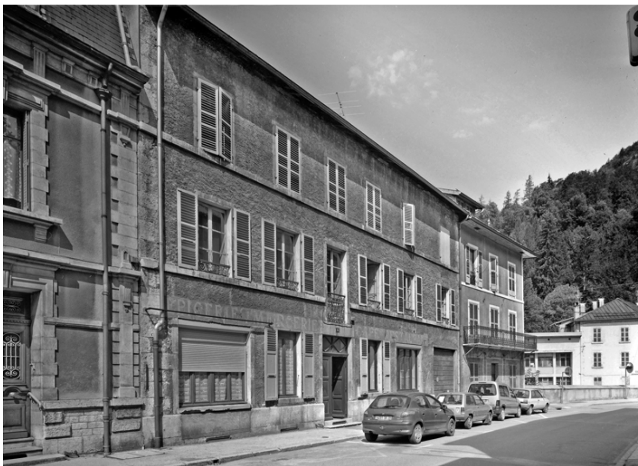
Elévation antérieure, de trois quarts gauche.
