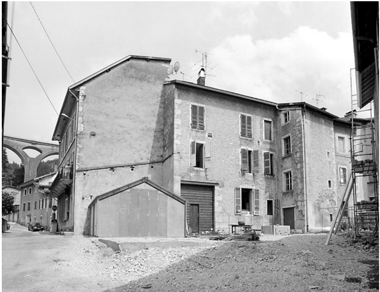
Elévation postérieure, de trois quarts gauche.
