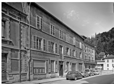
Elévation antérieure, de trois quarts gauche. Phot. Yves Sancey IVR43_20033900124V
