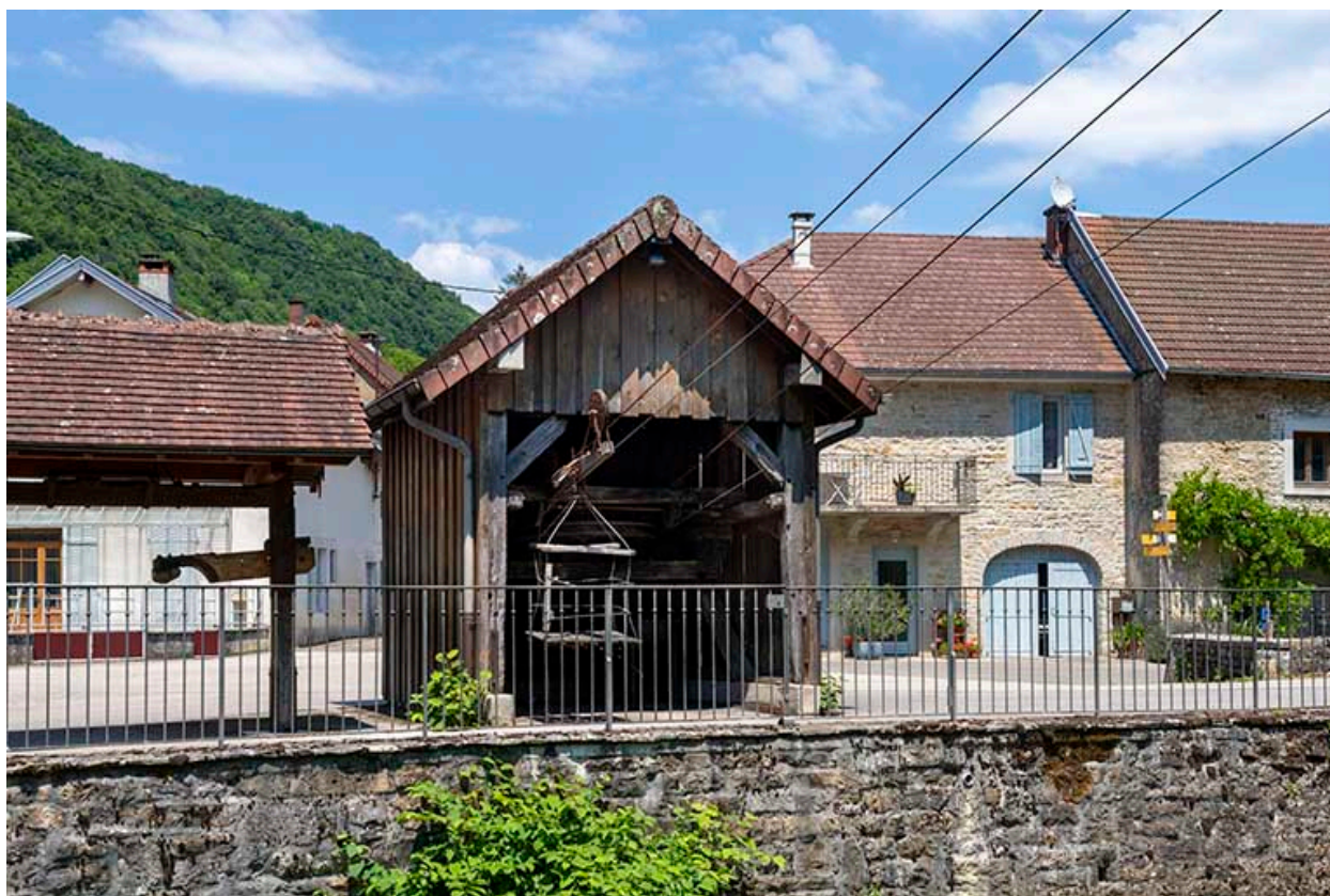
2020. Vue d'ensemble du transporteur automatique par câbles.
