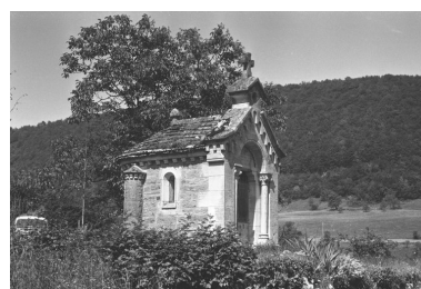
Oratoire situé au lieudit Au Meulenot. Phot. Guy Forestier IVR43_19743900598Z
