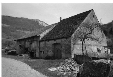
Ferme située rue du Chalet. Phot. F. Pernin IVR43_19743900109Z
