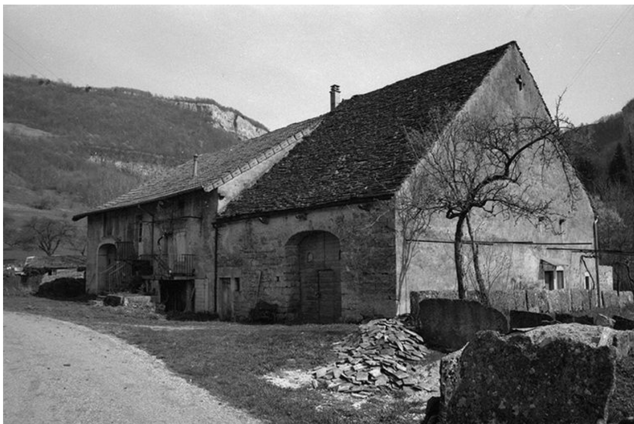
Ferme située rue du Chalet.
