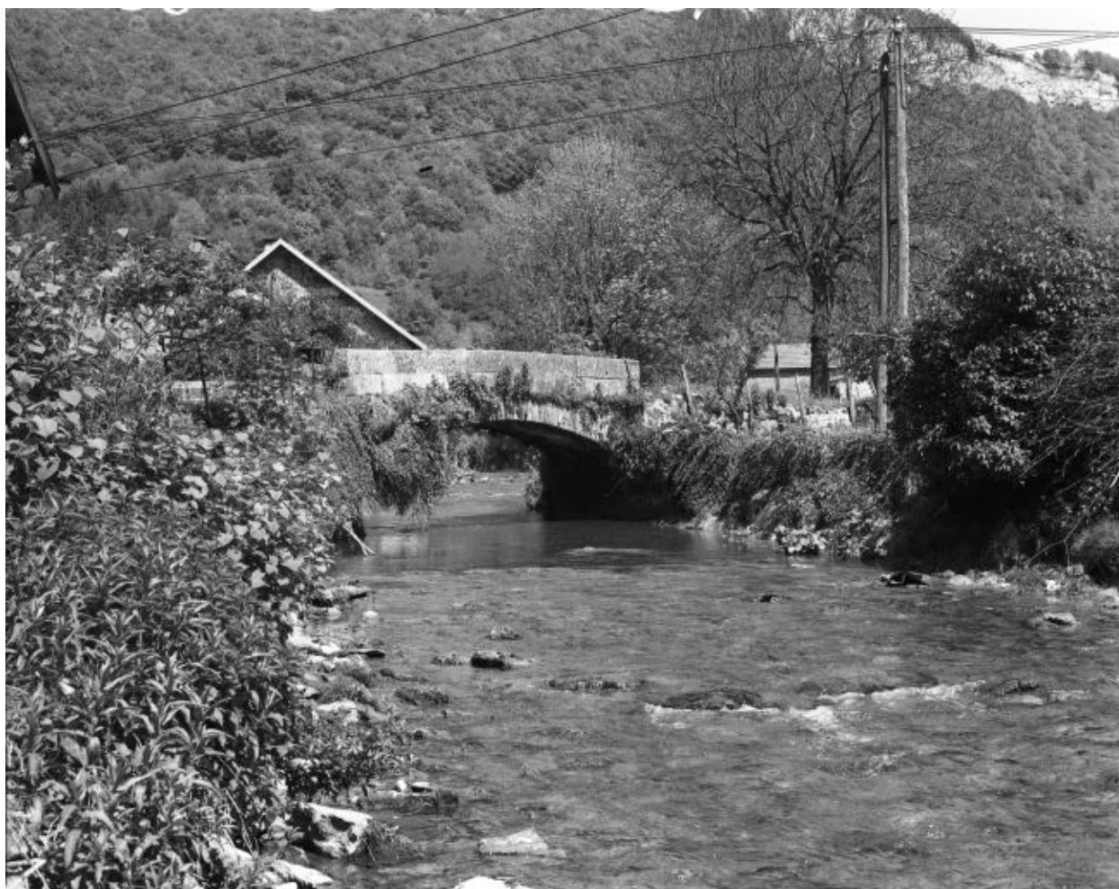
Pont situé sur le chemin de Blois-sur-Seille à Chaumois-Boivin.
