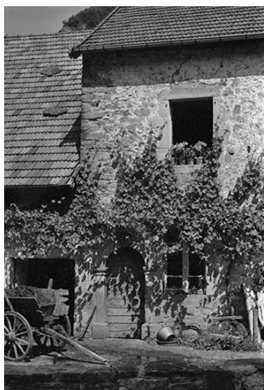
Ancien presbytère. Phot. Guy Forestier IVR43_19743900595Z
