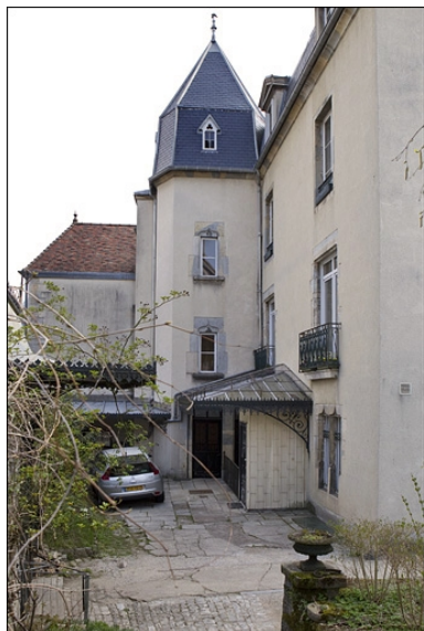
Logis principal : détail de la tour d'escalier. Phot. Yves Sancey IVR43_20102500429NUC2A
