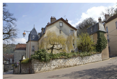
Vue d'ensemble de trois quarts droit depuis la rue.
