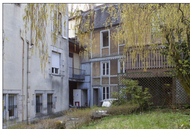
Détail de l'aile sur cour, de trois quarts droit. Phot. Yves Sancey IVR43_20102500428NUC2A
