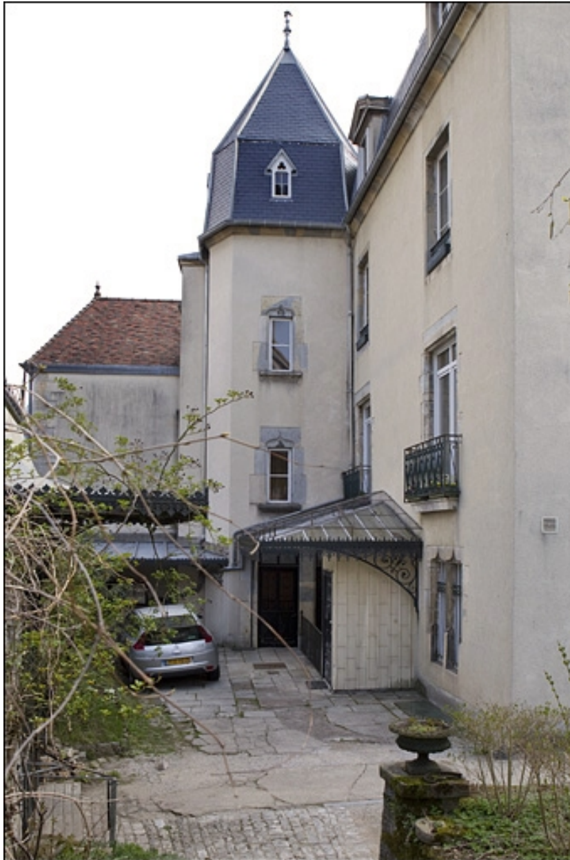
Logis principal : détail de la tour d'escalier.
