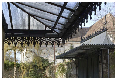
Détail du toit en tôle du portail dans clôture, depuis la porte du logis principal. Phot. Yves Sancey IVR43_20102500430NUC2A
