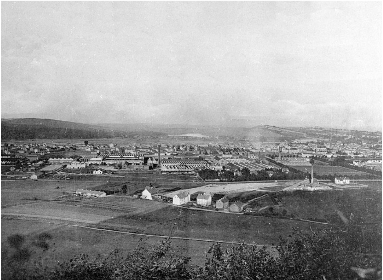
Vue générale de l'usine de Belfort.
