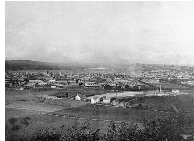
Vue générale de l'usine de Belfort. Phot. Jérôme Mongreville, Autr. Ernest (photographe) Mésière IVR43_20019000223X
