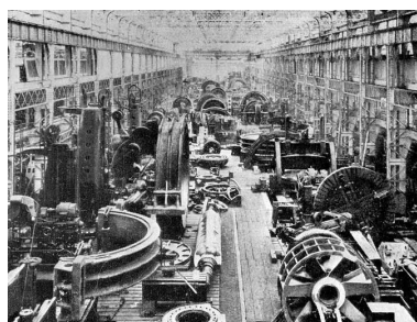
Atelier de gros usinage. Phot. Jérôme Mongreville IVR43_20019000495X
