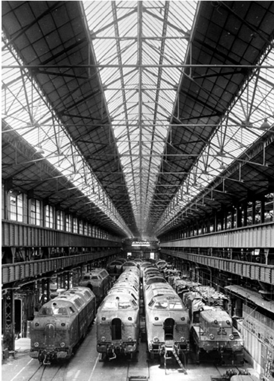
Hall de montage des locomotives diesel-électriques.
