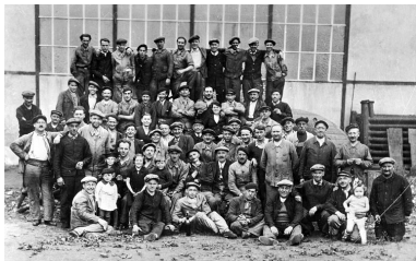
Groupe d'ouvriers. Phot. Jérôme Mongreville IVR43_20019000113X
