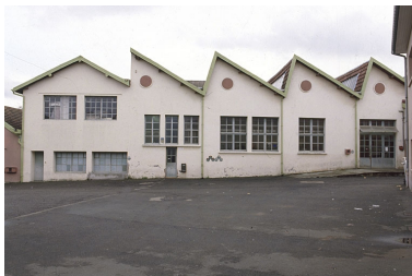
Pignons nord de l'ancien atelier de fabrication.
