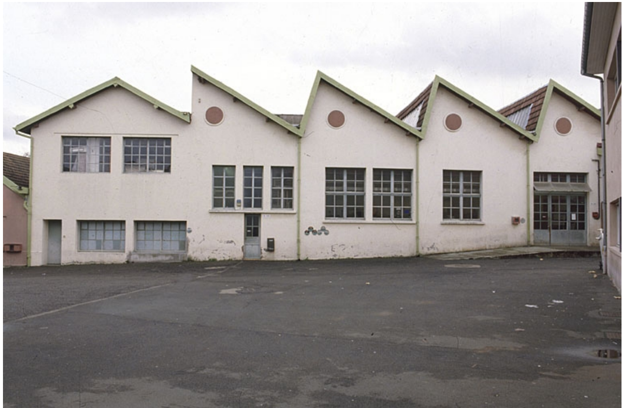
Pignons nord de l'ancien atelier de fabrication.
