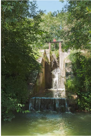
Vue du déversoir.
