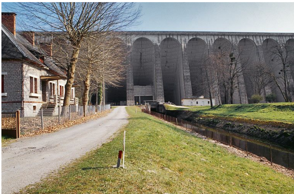
Vue d'aval : maisons et bureaux.
