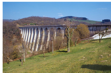
Vue d'ensemble de l'aval. Phot. Jean-Luc Duthu IVR26_20025800130ZA
