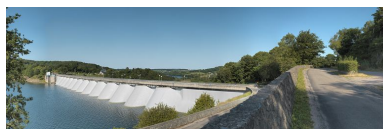
Vue générale du barrage. Phot. Thierry Kuntz IVR26_20135800394NUC4A
