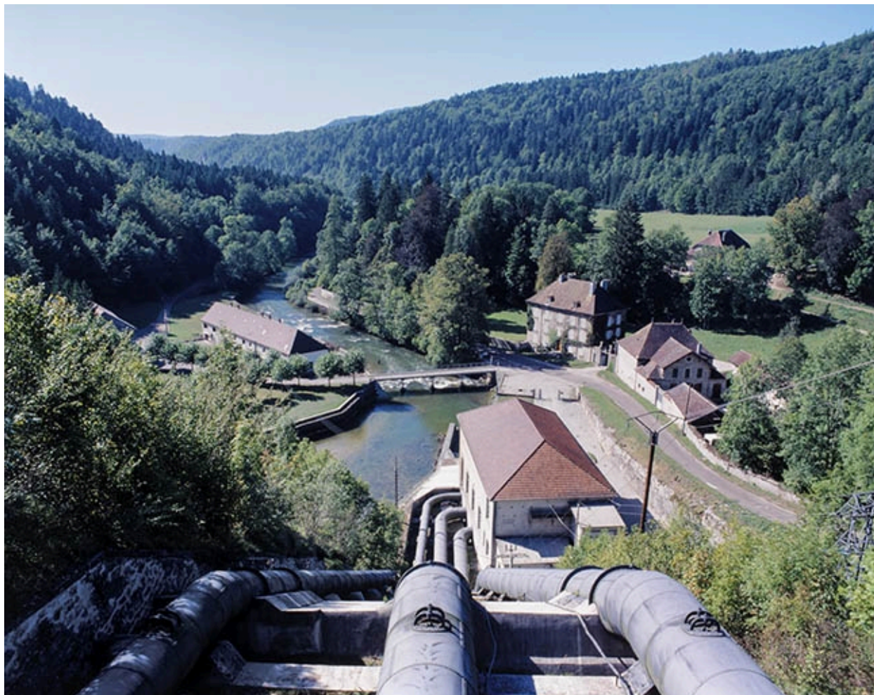
Le site depuis le haut de la conduite forcée.
