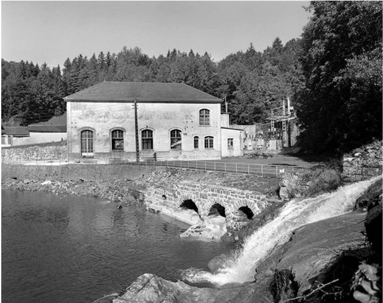
Façade postérieure de la centrale.
