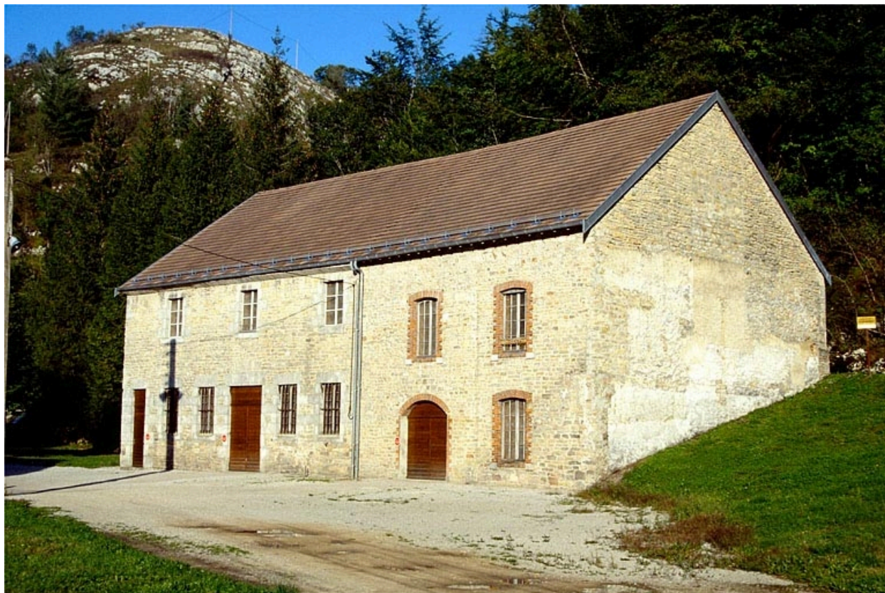
Logement d'ouvriers et magasin industriel (ancienne hall à charbon ?).
