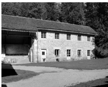
Bâtiment des communs. Phot. Jérôme Mongreville IVR43_19913900608X
