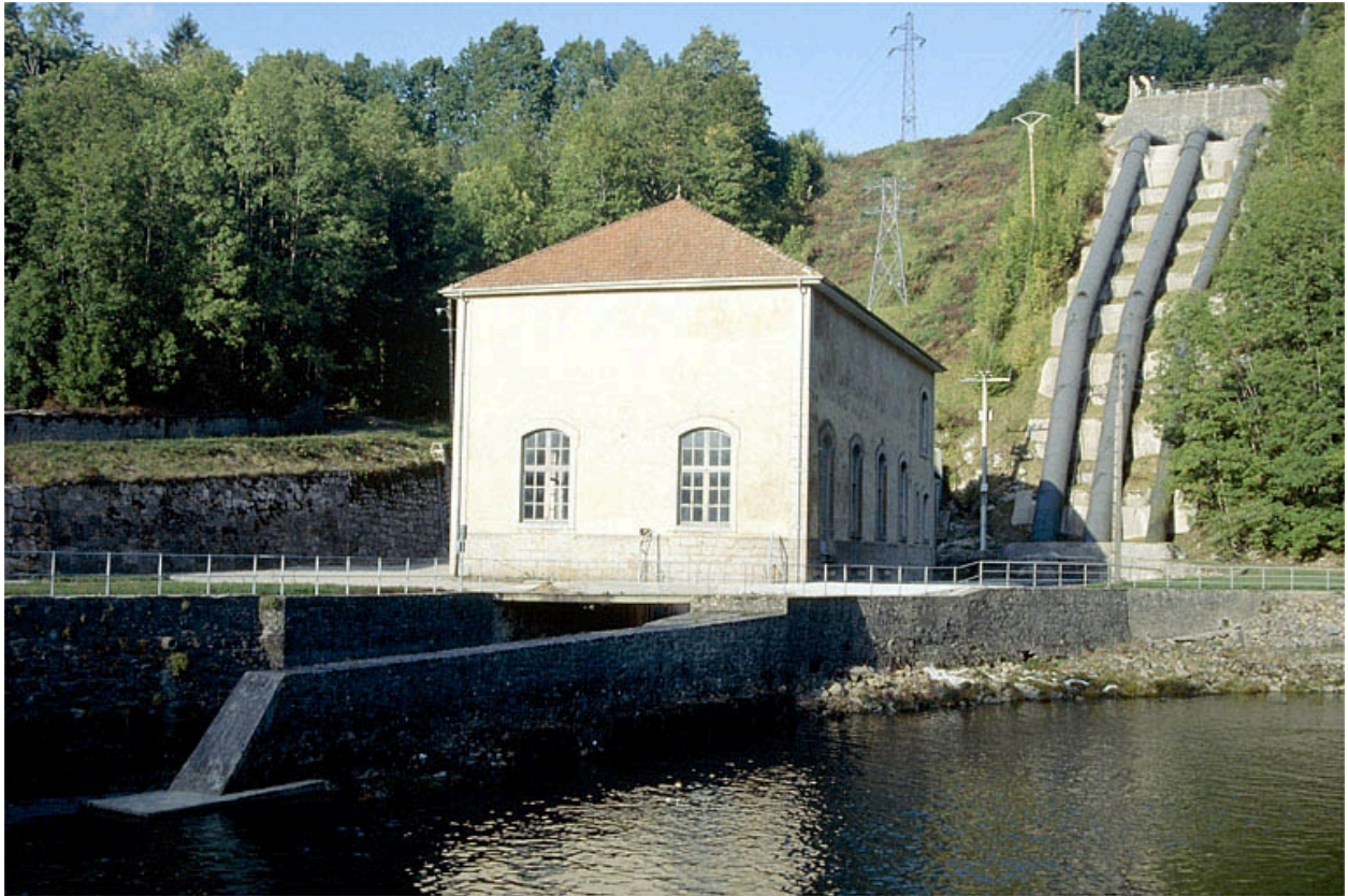
Façade latérale droite de la centrale et conduite forcée.
