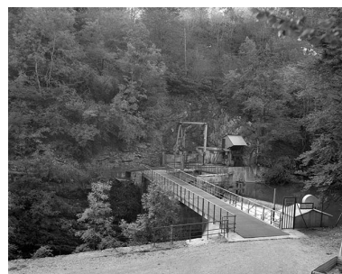
Vue d'ensemble de la prise d'eau. Phot. Jérôme Mongreville IVR43_19913900595X
