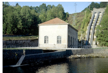
Façade latérale droite de la centrale et conduite forcée. Phot. Jérôme Mongreville IVR43_19913900585ZA
