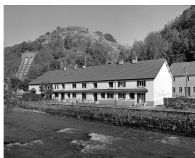
Logements d'ouvriers. Phot. Jérôme Mongreville IVR43_19913900576X
