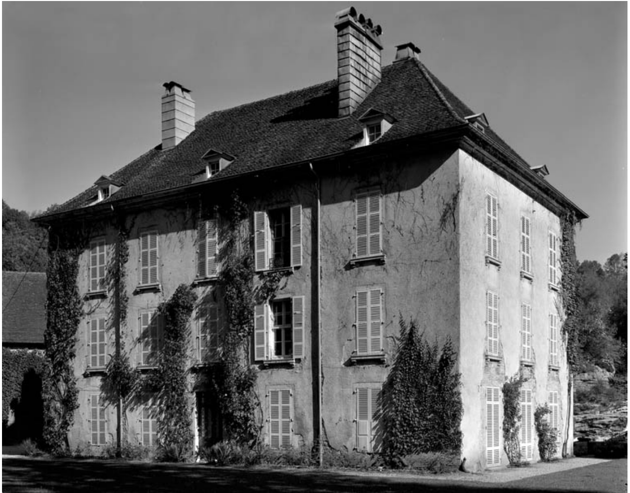
Façade postérieure du logement patronal, vue de trois quarts droite.
