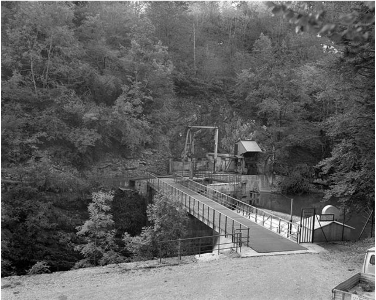
Vue d'ensemble de la prise d'eau.
