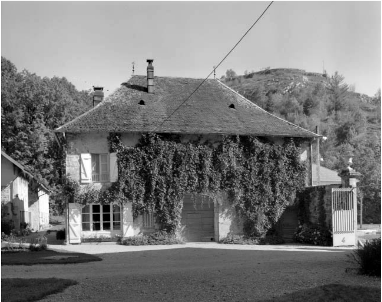
Façade antérieure du bâtiment abritant logement de domestiques et remise.
