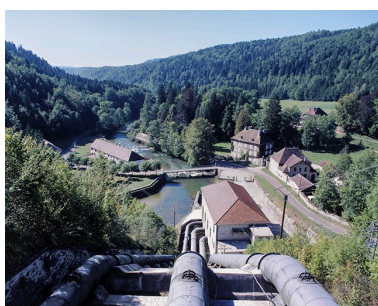
Le site depuis le haut de la conduite forcée. Phot. Jérôme Mongreville IVR43_19913900569XA
