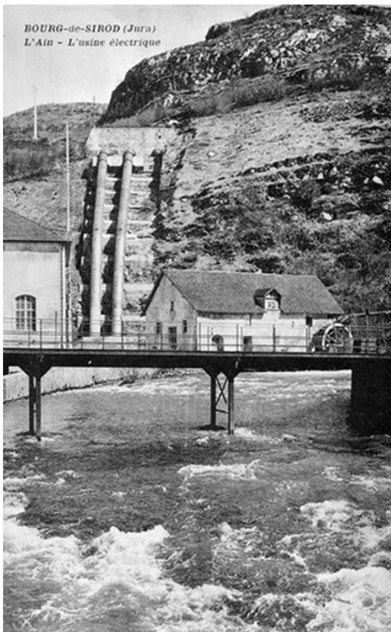
Bourg-de-Sirod (Jura). L'Ain - L'usine électrique.
