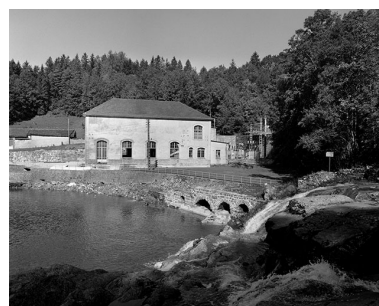
Vue d'ensemble de la centrale depuis la cascade. Phot. Jérôme Mongreville IVR43_19913900579X
