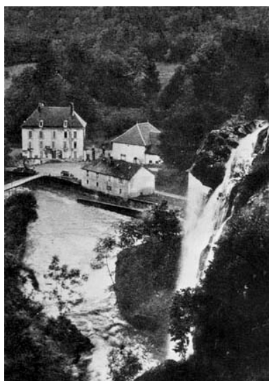
Les Forges - Cascade après la perte de l'Ain. Phot. IVR43_19813900329V
