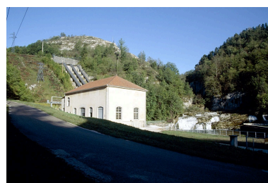
Vue d'ensemble de la centrale et de la cascade. Phot. Jérôme Mongreville IVR43_19913900581ZA
