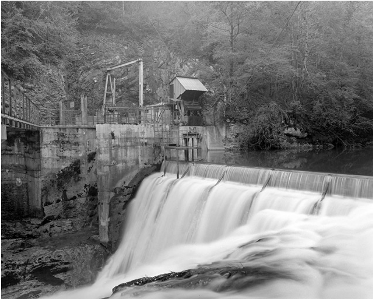
Prise d'eau et barrage.
