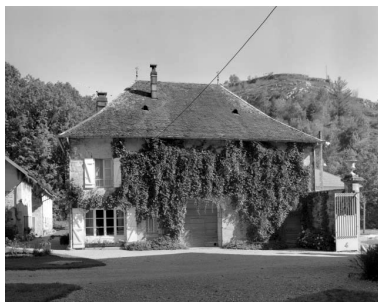
Façade antérieure du bâtiment abritant logement de domestiques et remise. Phot. Jérôme Mongreville IVR43_19913900605X
