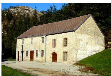
Logement d'ouvriers et magasin industriel (ancienne hall à charbon ?). Phot. Jérôme Mongreville IVR43_19913900578ZA
