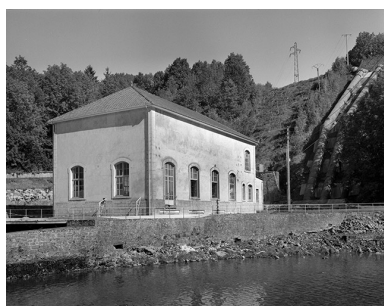
Façade postérieure de la centrale, vue de trois quarts gauche. Phot. Jérôme Mongreville IVR43_19913900586X
