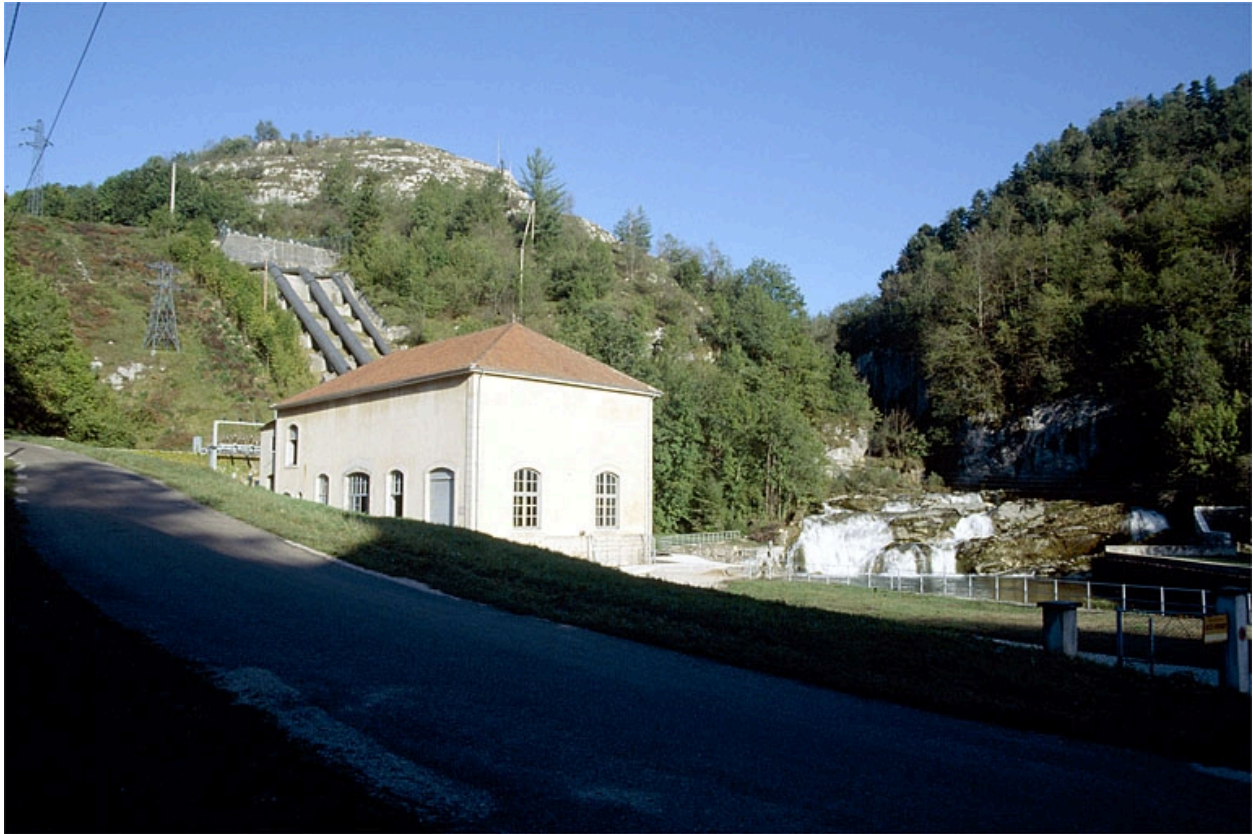
Vue d'ensemble de la centrale et de la cascade.
