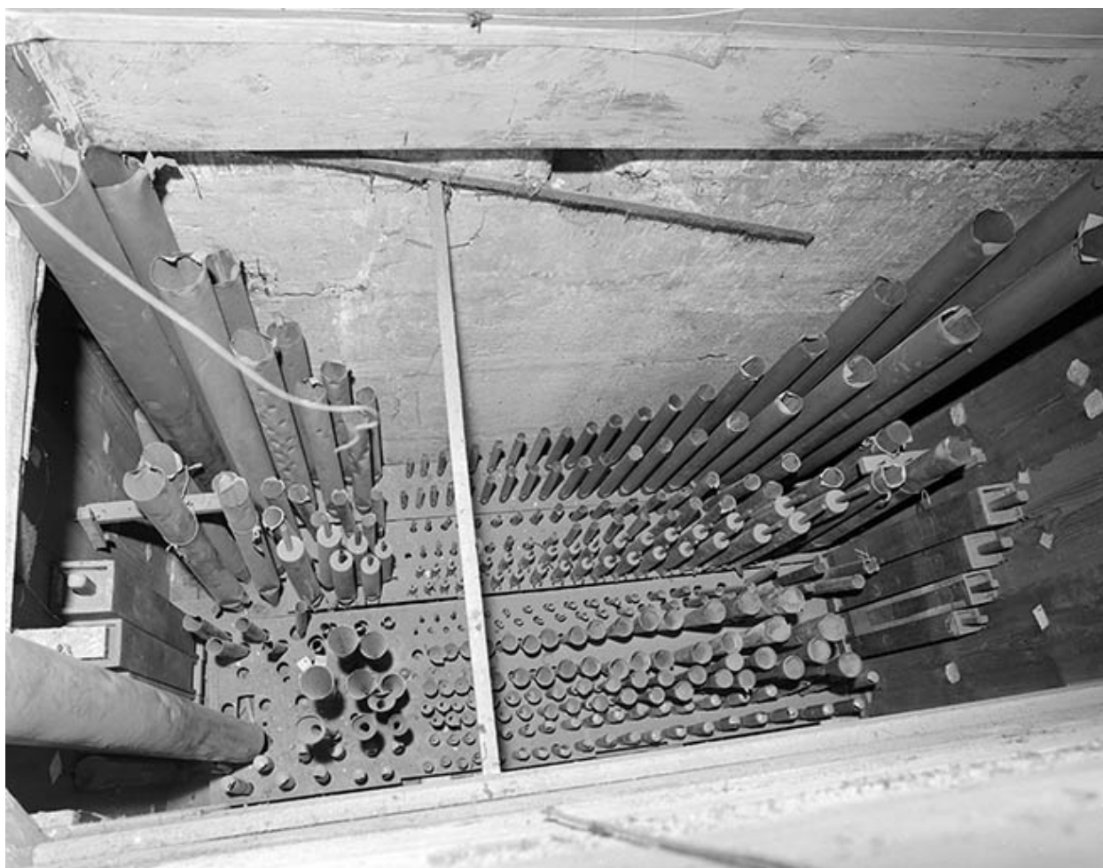
Tuyauterie de l'écho, vue en plongée.
