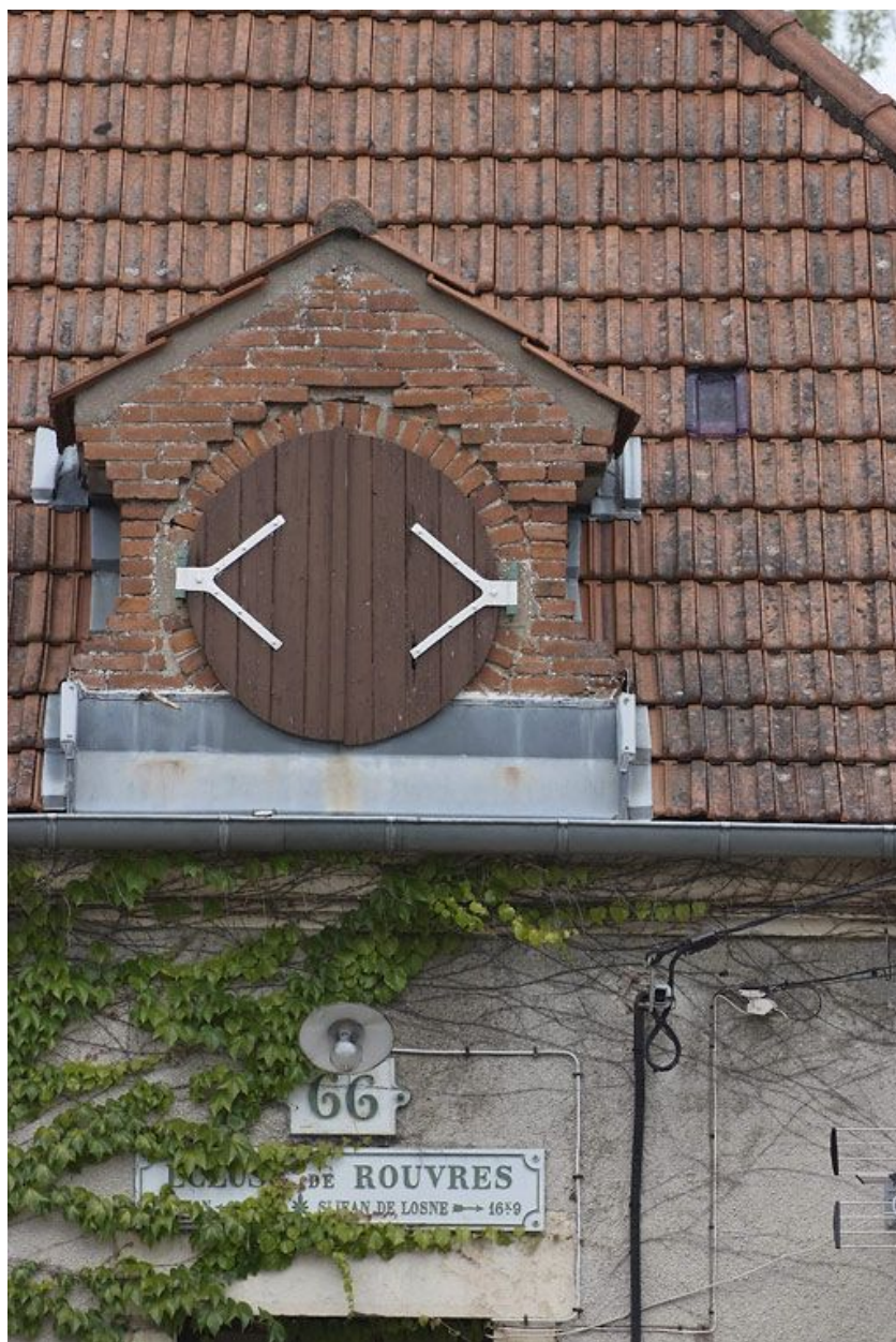
Détail de l'oeil-de-boeuf de la façade.
