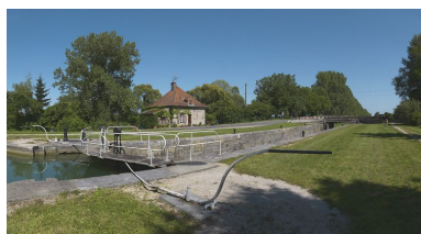
Vue d'amont. Phot. Thierry Kuntz IVR26_20112103124NUC4A
