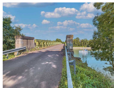
Vue du dessus du pont, rive gauche. Phot. Thierry Kuntz IVR26_20217100497NUC4A
