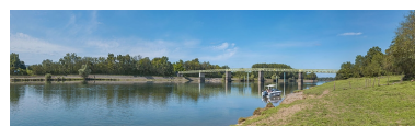
Le pont vu d'aval depuis la rive gauche. Phot. Thierry Kuntz IVR26_20217100499NUC4A
