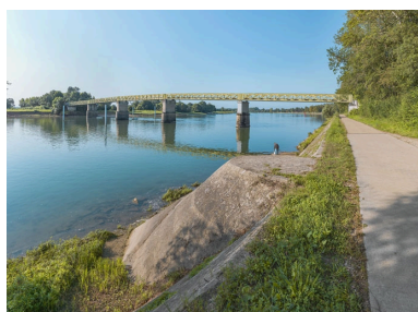
Vue d'ensemble du pont d'amont et depuis la rive droite. Perrés et rampe au premier plan. Phot. Thierry Kuntz IVR26_20217100496NUC4A
