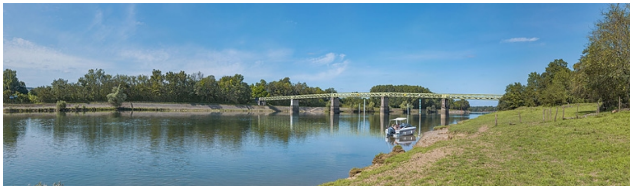
Le pont vu d'aval depuis la rive gauche.
