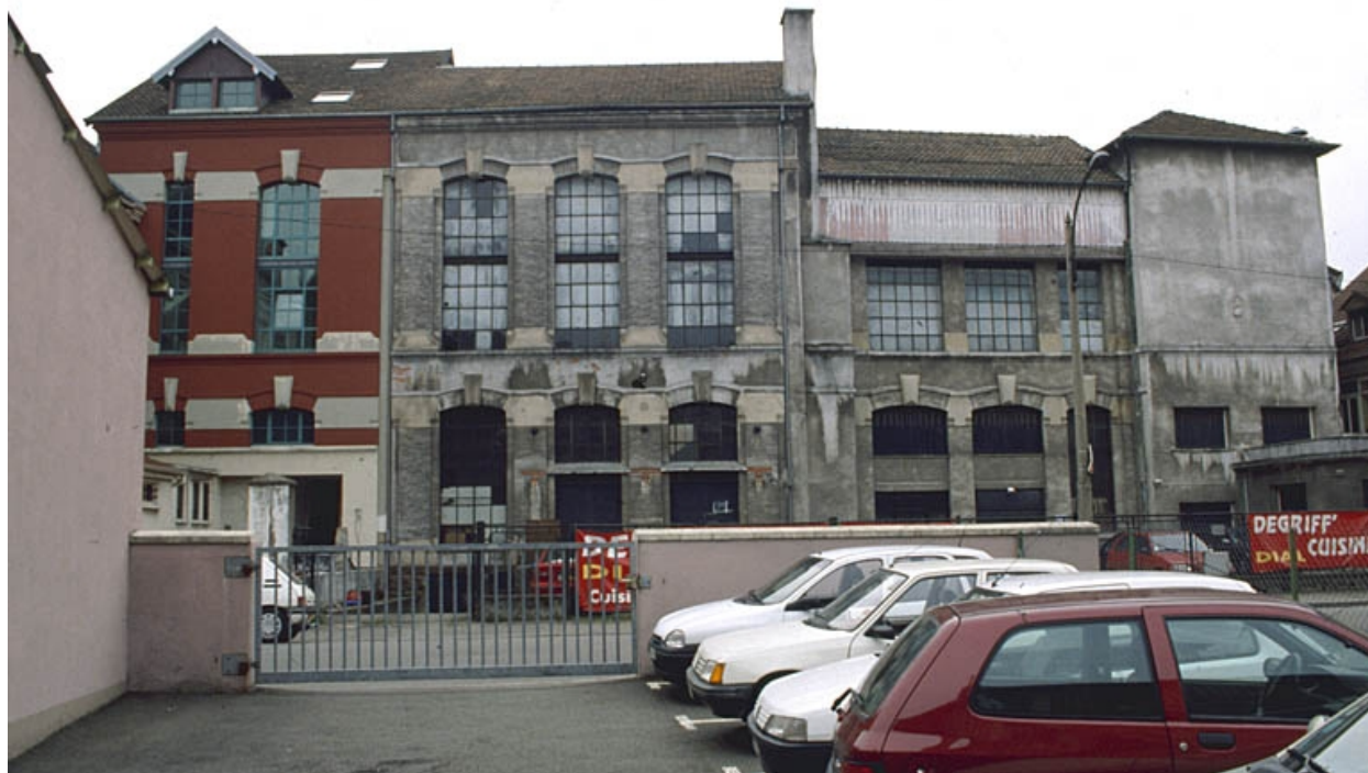
Façade antérieure de l'atelier de fabrication.
