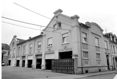
Bâtiment abritant des remises et des logements. Phot. Yves Sancey IVR43_20009000658X
