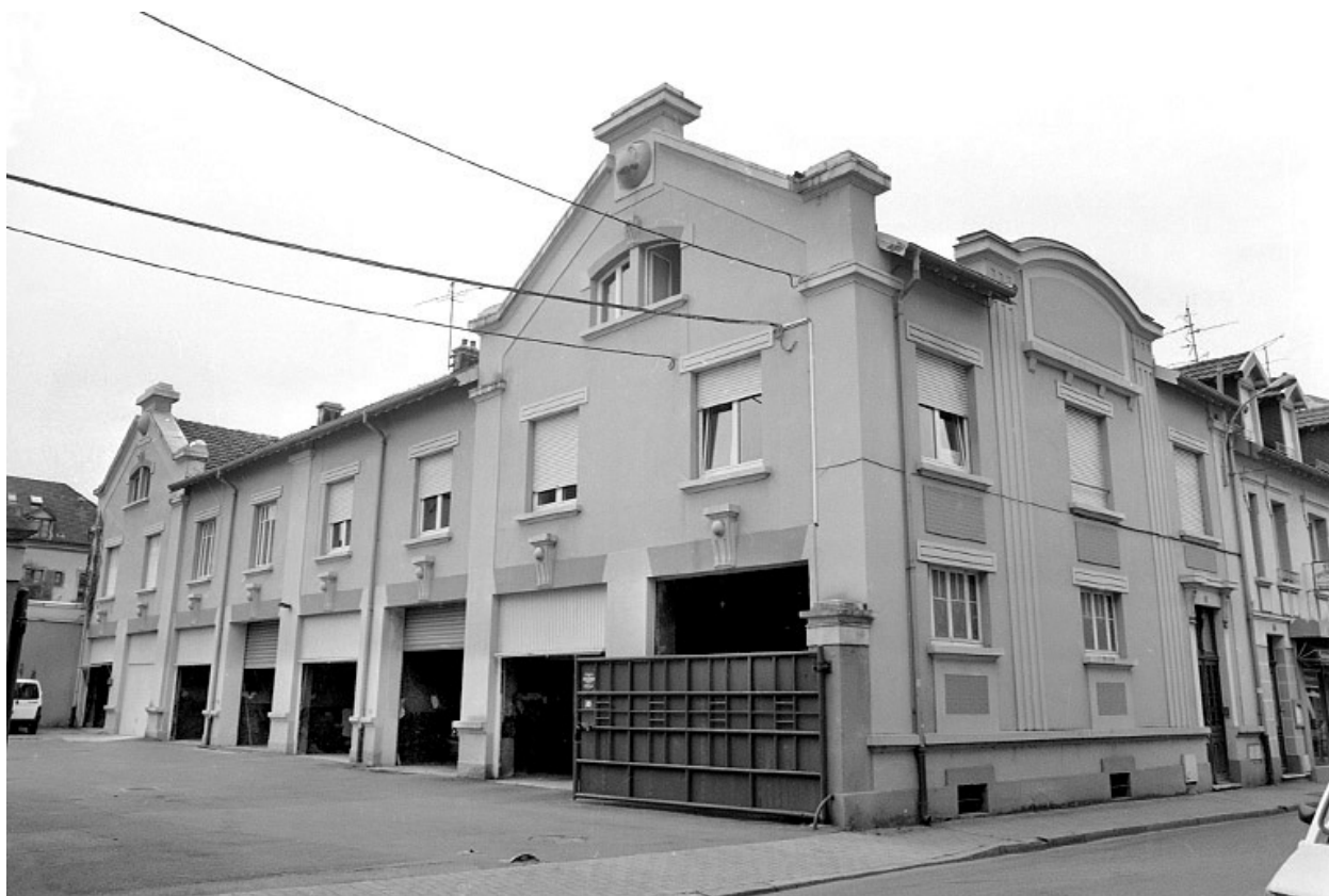
Bâtiment abritant des remises et des logements.
