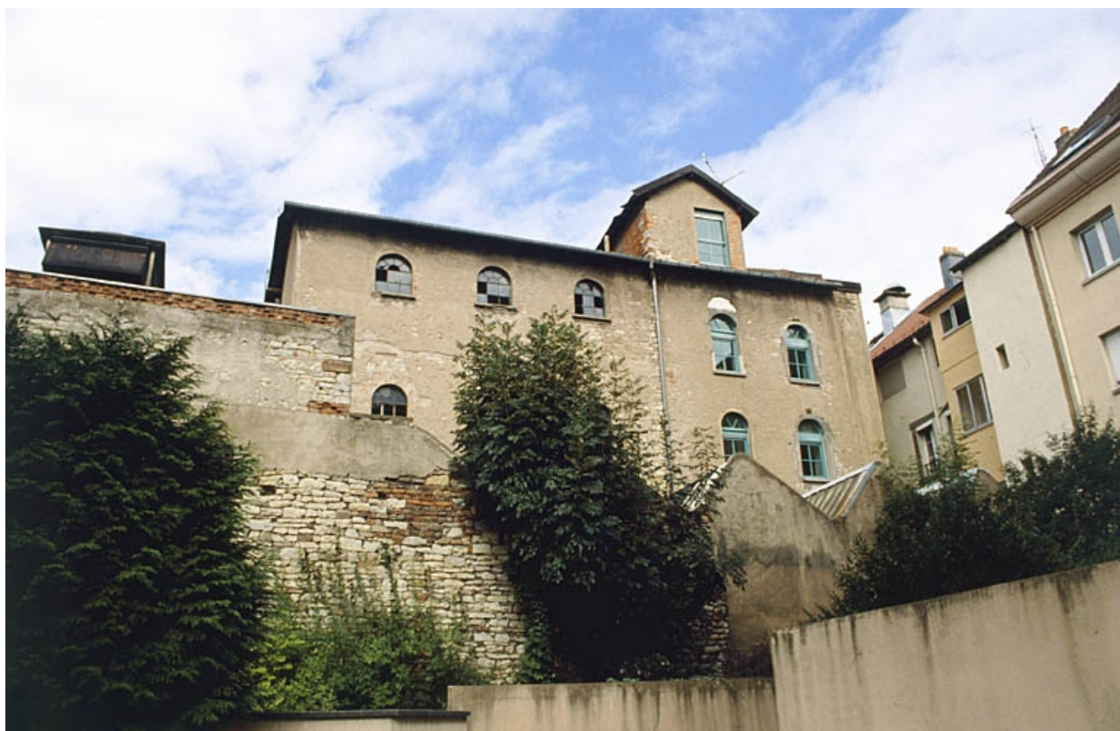
Façade postérieure de l'usine.
