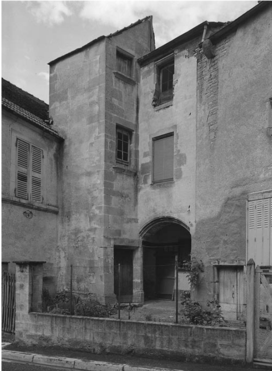
Maison et corps de passage. Façades sur rue.
