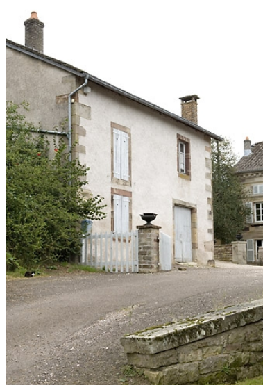
Logement des domestiques, depuis l'entrée. Phot. Jérôme Mongreville IVR43_20077000439NUCA
