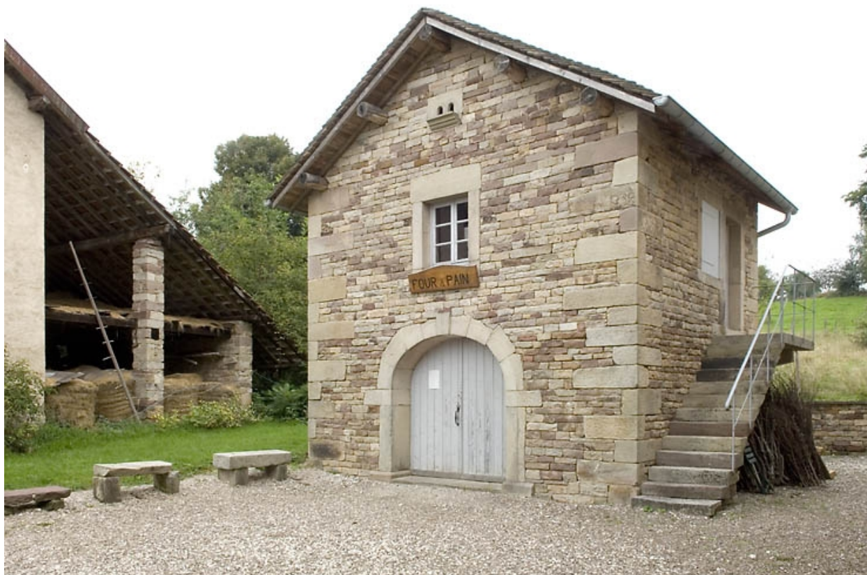
Four à pain. Vue de trois quarts.
