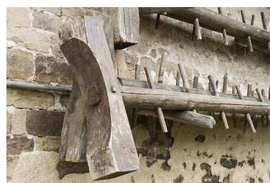
Pieds de chèvre. Détail. Phot. Jérôme Mongreville IVR43_20077000447NUCA
