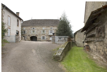
Vue d'ensemble depuis l'ancienne entrée. Phot. Jérôme Mongreville IVR43_20077000430NUCA
