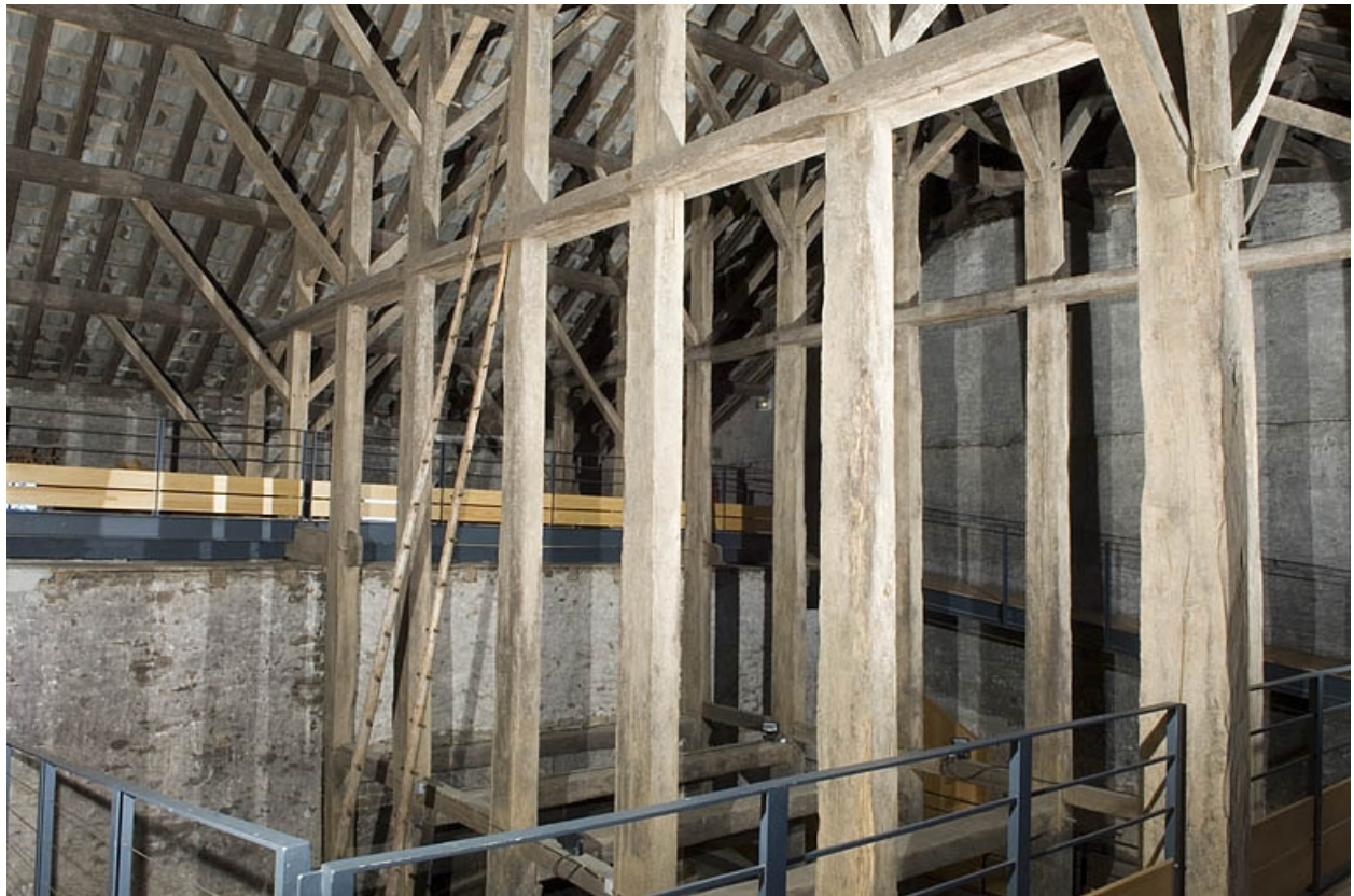
Charpente du fenil (cadrage vertical).
