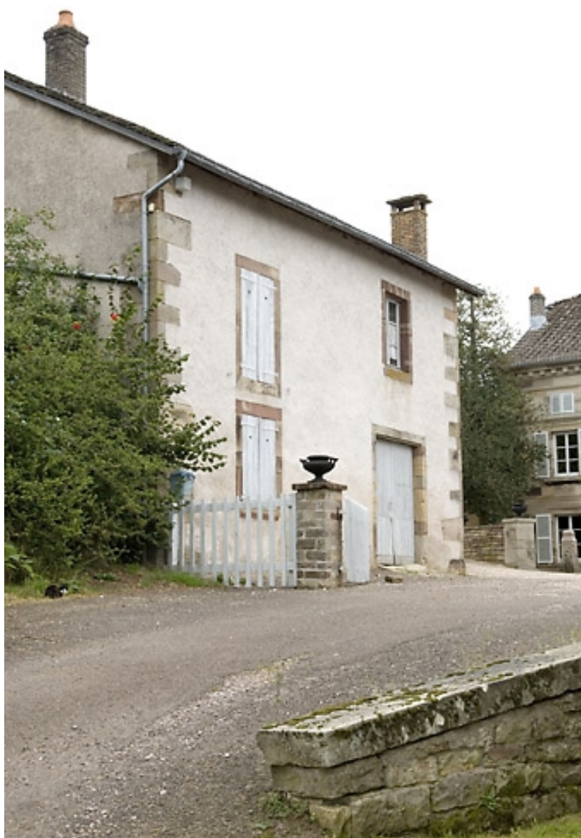
Logement des domestiques, depuis l'entrée.
