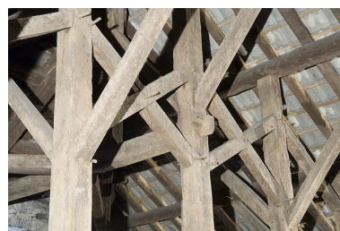
Charpente du fenil. Détail de partie haute (contrefiches et croix de Saint-André). Phot. Jérôme Mongreville IVR43_20067000790NUCA
