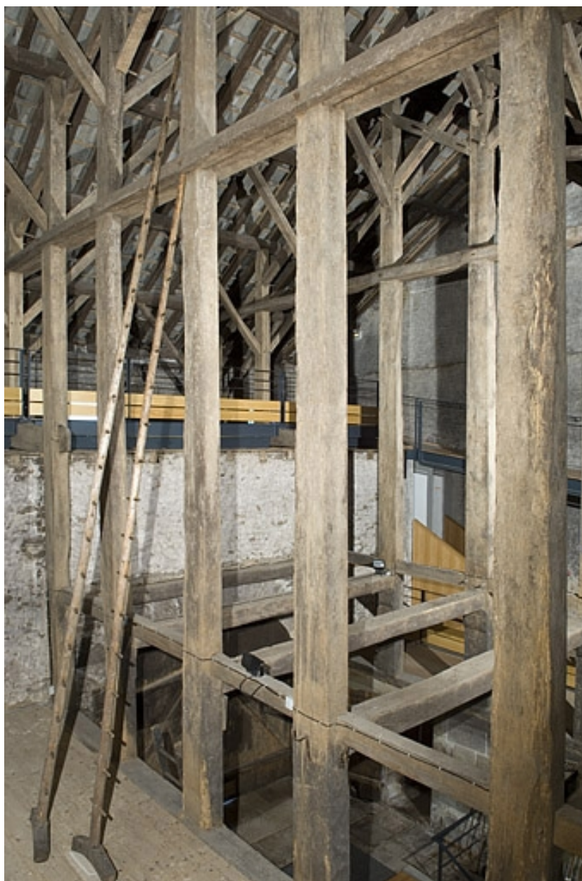
Charpente du fenil. Vue plongeante.
