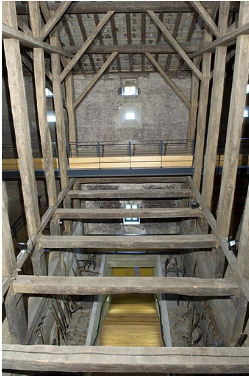
Charpente du fenil. travée centrale.
