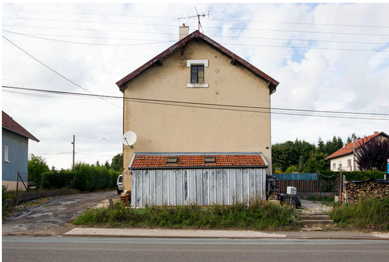
Immeuble au n° 7 : façade latérale sud.
