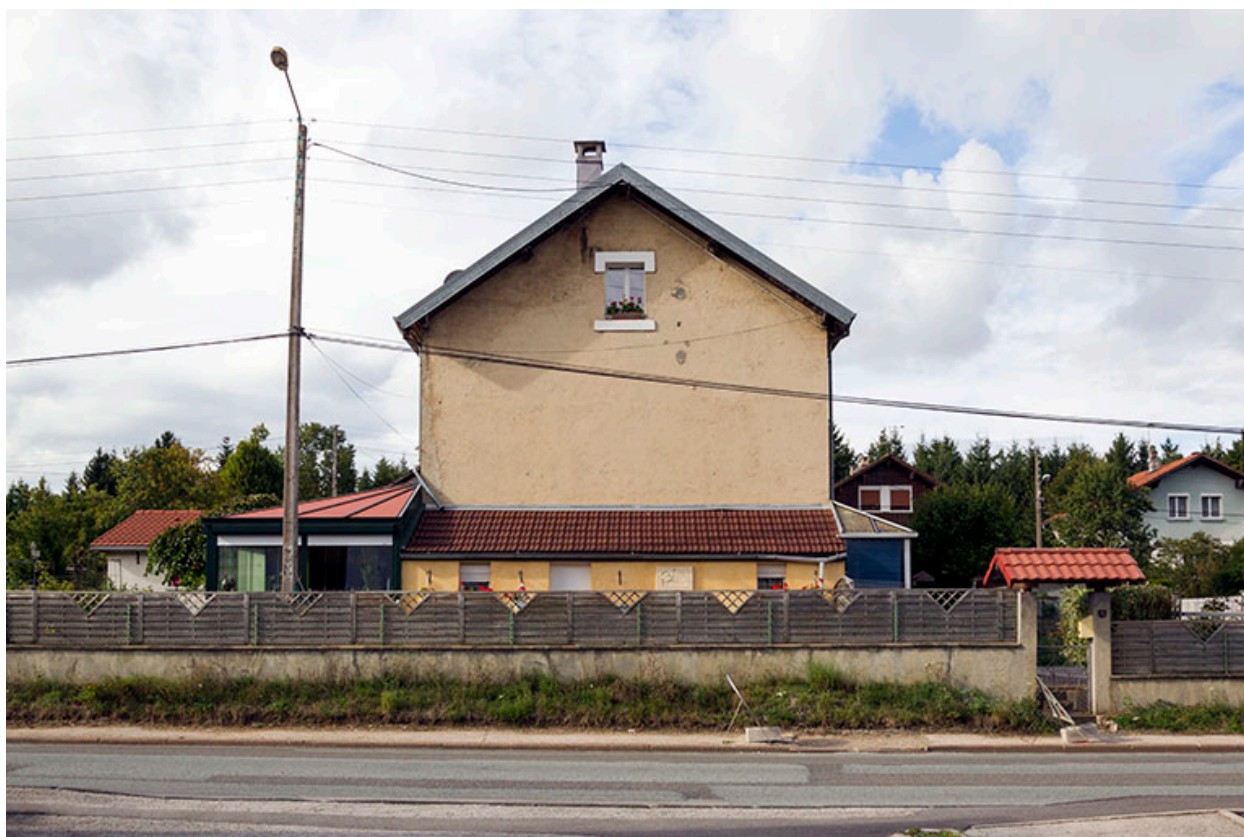
Immeuble au n° 9 : façade latérale sud.
