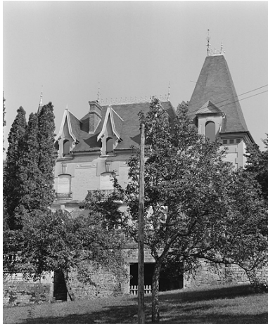
Façade antérieure, vue générale. Phot. Yves Sancey IVR43_19853900321X
