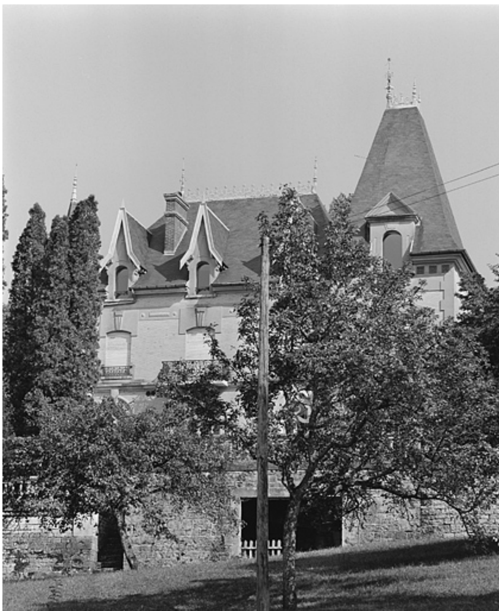
Façade antérieure, vue générale.
