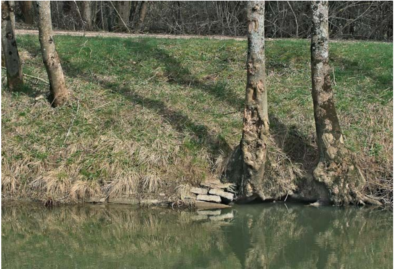
Emplacement de l'aqueduc du Pont à Bascule, désordres dans le perré.
