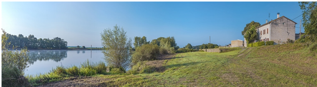
Le port de Farges : mur de soutènement.
