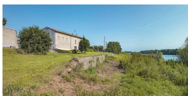
Mur de soutènement du port de Farges. Phot. Thierry Kuntz IVR26_20217100490NUC4A
