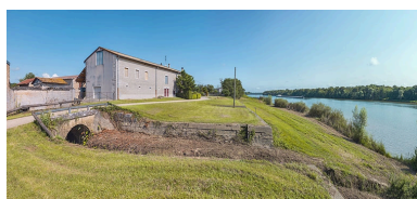
Le port de Farges : ponton et mur de soutènement. Phot. Thierry Kuntz IVR26_20217100491NUC4A
