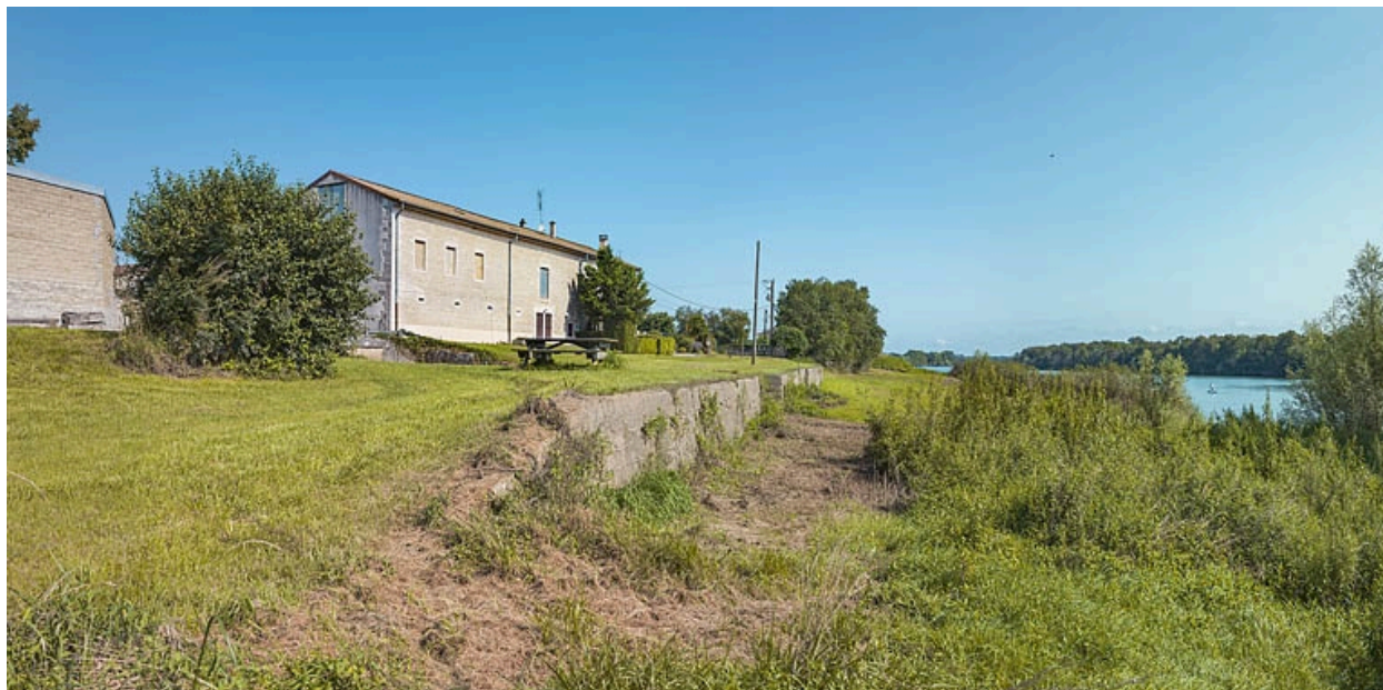
Mur de soutènement du port de Farges.
