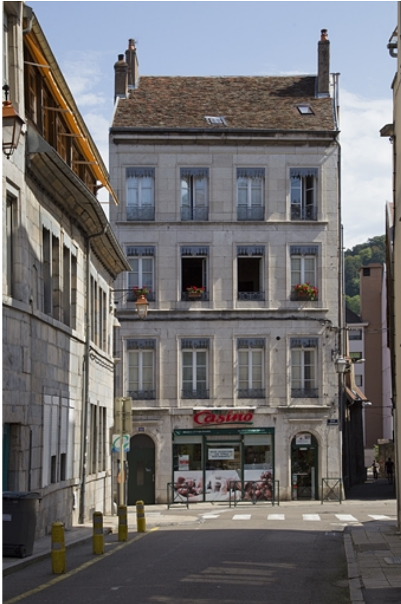
Logis principal : façade antérieure, de face.
