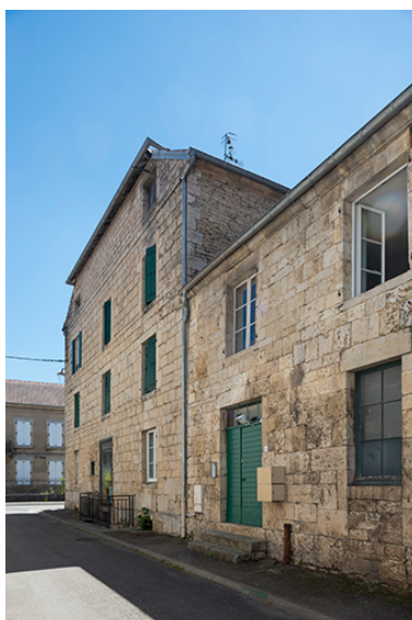
Élévation sur la rue des Forges. Phot. Jérôme Mongreville IVR43_20187000439NUC4A
