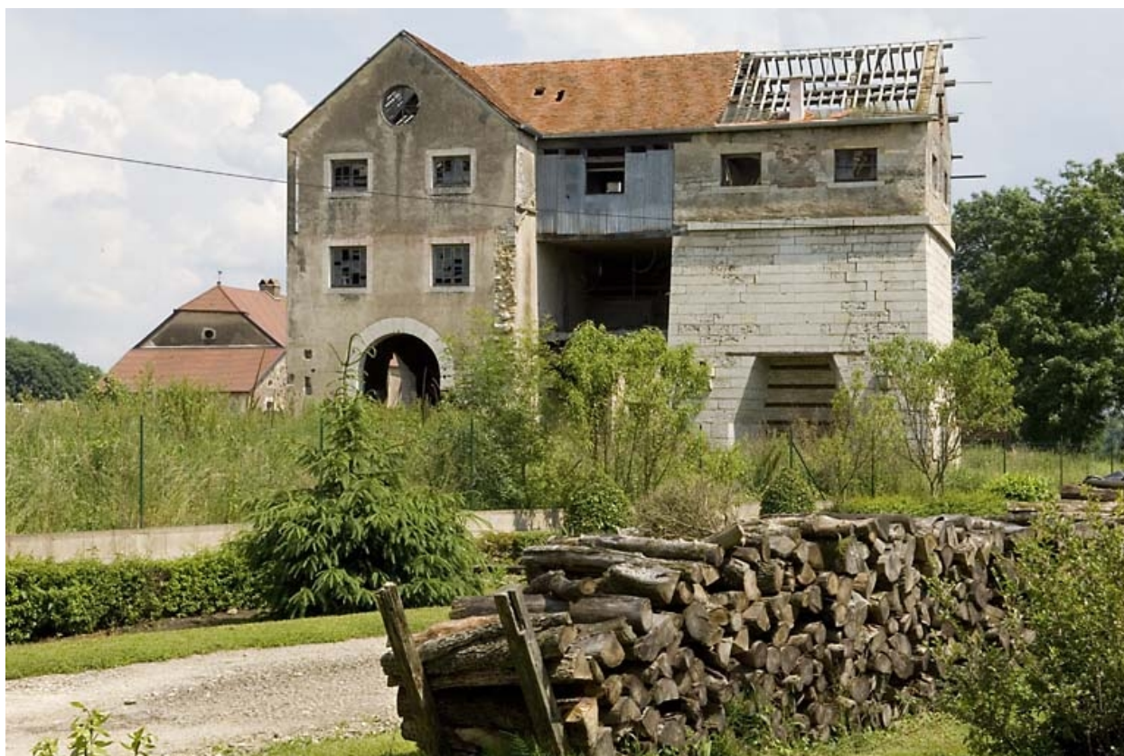
Façade antérieure du haut fourneau.
