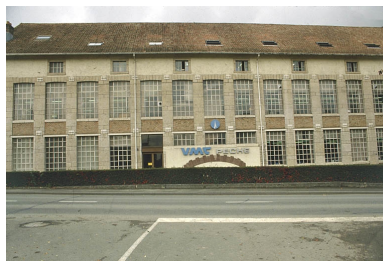
Façade antérieure vue de face. Phot. Yves Sancey IVR43_20009000777ZA
