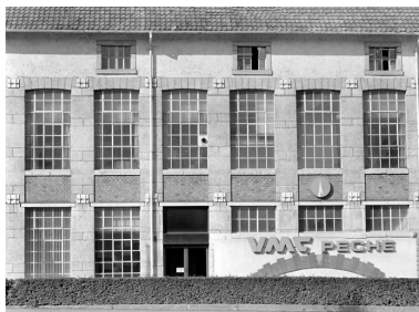
Détail de travées de la façade antérieure. Phot. Yves Sancey IVR43_20009000778X
