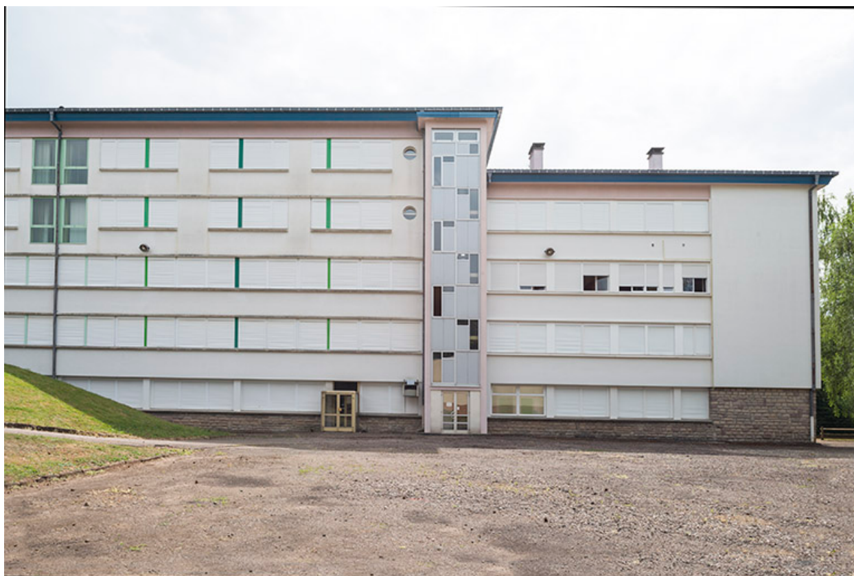
Externat : façade postérieure.
