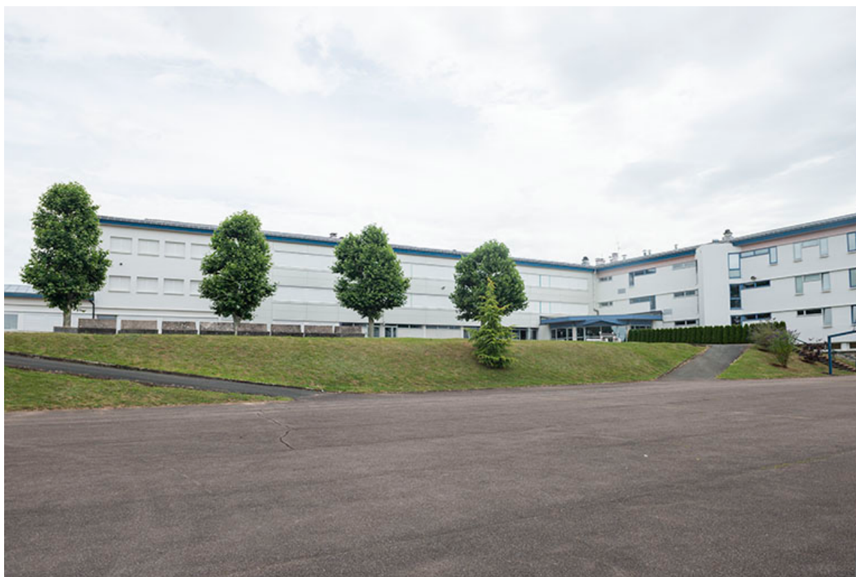
Externat et atelier : façades sur cour.
