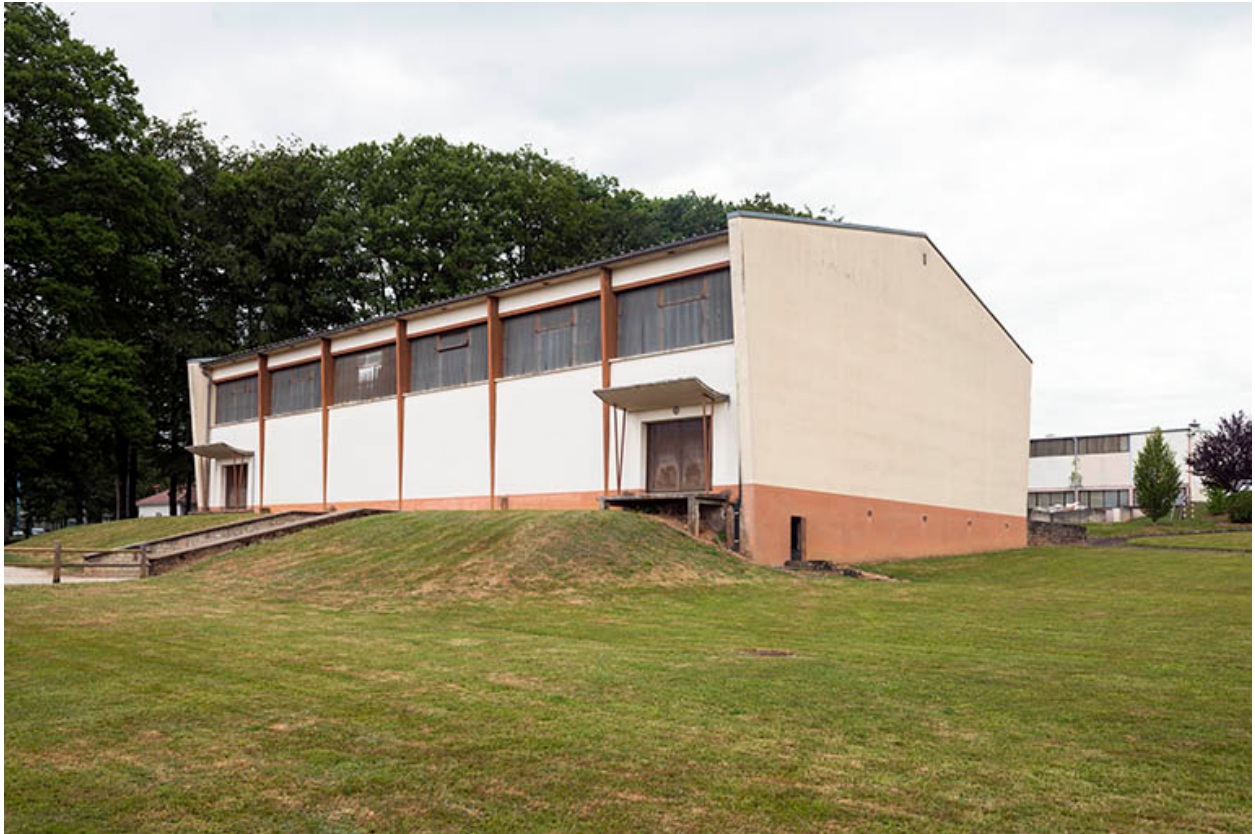
Gymnase : vue postérieure.
