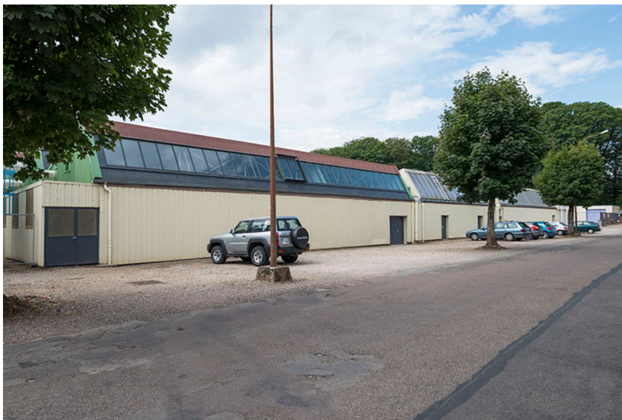
Ateliers : façade antérieure.
