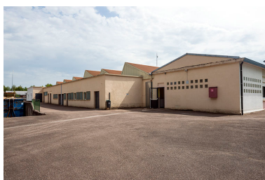
Ateliers : vue générale. Phot. Mary Ruffinoni IVR43_20147000132NUC4A
