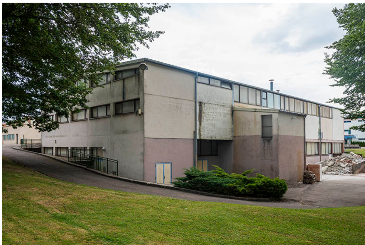
Atelier de gros-oeuvre : façade postérieure.
