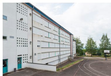
Externat : ensemble des façades arrière. Phot. Mary Ruffinoni IVR43_20147000143NUC4A
