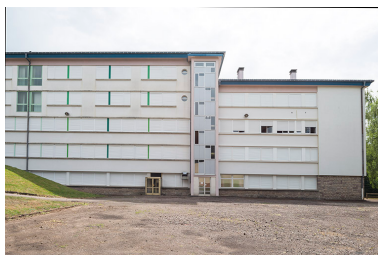
Externat : façade postérieure. Phot. Mary Ruffinoni IVR43_20147000142NUC4A
