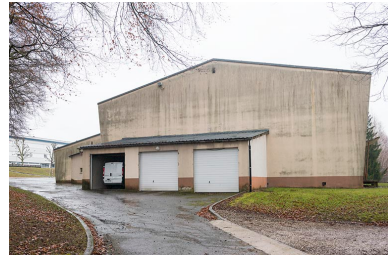
Façade postérieure - ouest - du gymnase. Phot. Mary Ruffinoni IVR43_20157000101NUC4A
