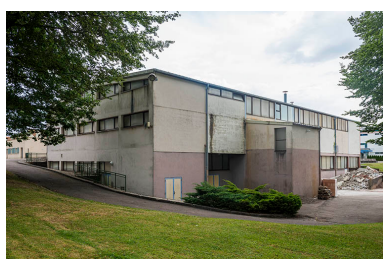
Atelier de gros-oeuvre : façade postérieure. Phot. Mary Ruffinoni IVR43_20147000135NUC4A
