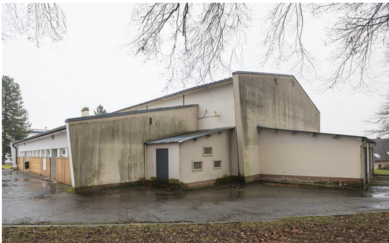
Angle nord-ouest du gymnase.
