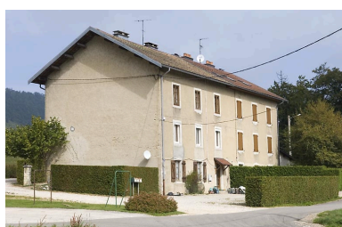
Immeuble de logements, au nord-ouest. Phot. Jérôme Mongreville IVR43_20082501108NUC2A
