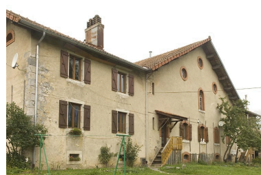
Habitation : façade antérieure, de trois quarts gauche. Phot. Jérôme Mongreville IVR43_20082501096NUC2A
