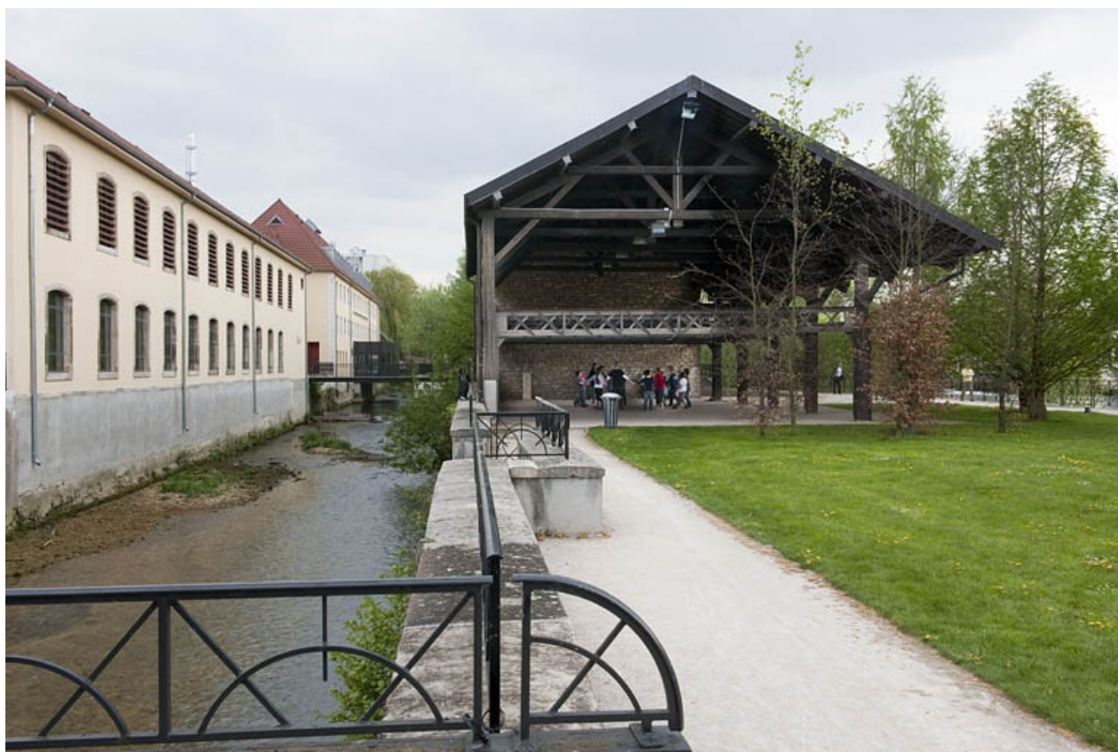
Ateliers de filature et hangar à bois.
