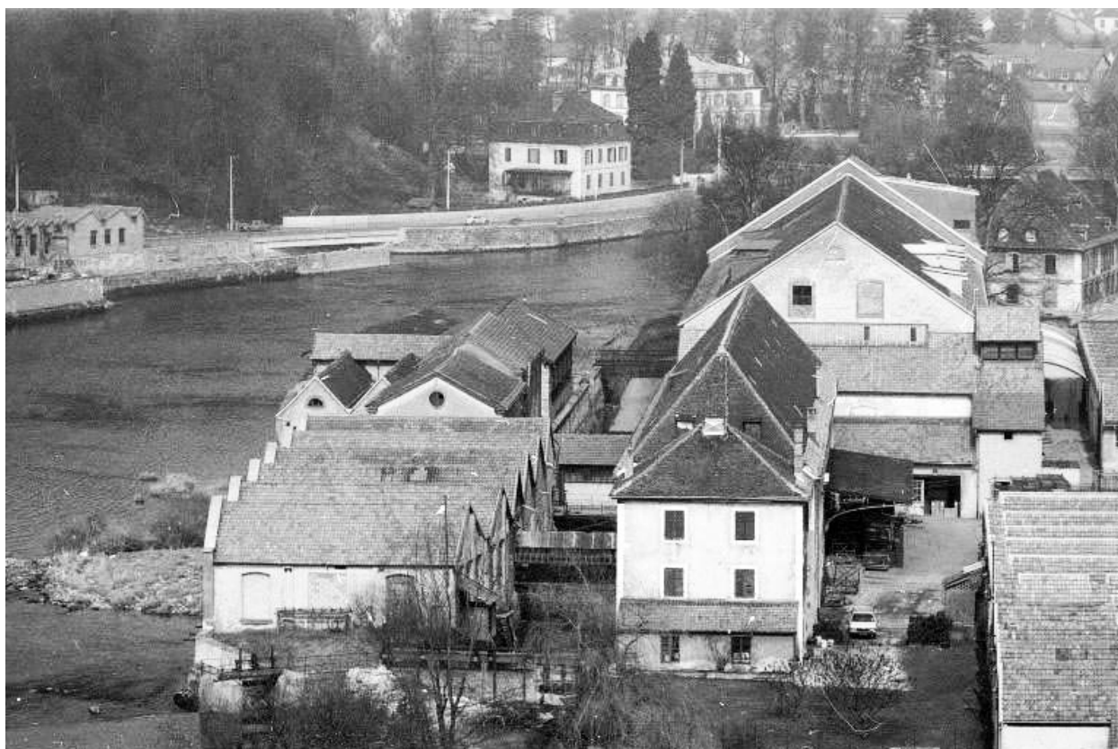
Vue plongeante depuis le sud en 1983.
