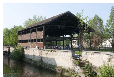
Hangar à bois. Phot. Jérôme Mongreville IVR43_20112501136NUC4A
