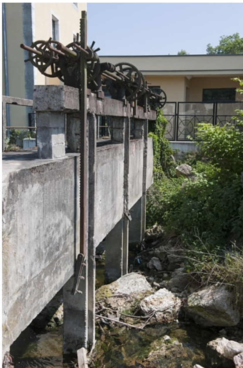
Système de vannage du bief de dérivation.
