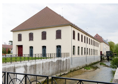
Atelier de filature nord depuis l'aval. Phot. Jérôme Mongreville IVR43_20112501131NUC4A
