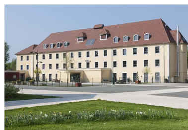
Atelier de filature sud. Phot. Jérôme Mongreville IVR43_20112501138NUC4A
