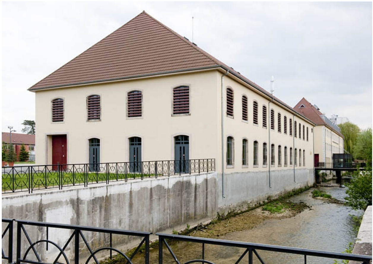
Atelier de filature nord depuis l'aval.
