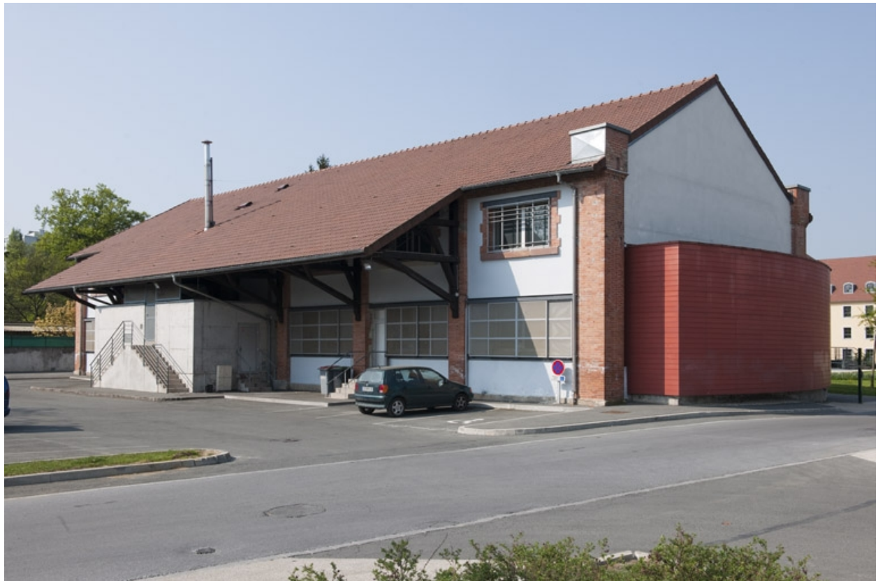
Entrepôt industriel à l'entrée du site.
