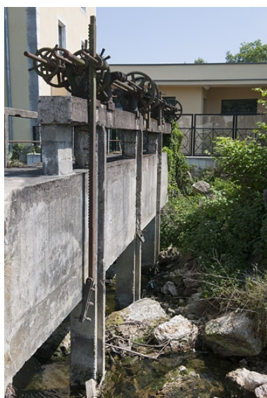
Système de vannage du bief de dérivation. Phot. Jérôme Mongreville IVR43_20112501141NUC4A
