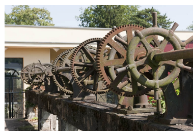
Système de vannage du bief de dérivation. Volants et engrenages. Phot. Jérôme Mongreville IVR43_20112502058NUC4A
