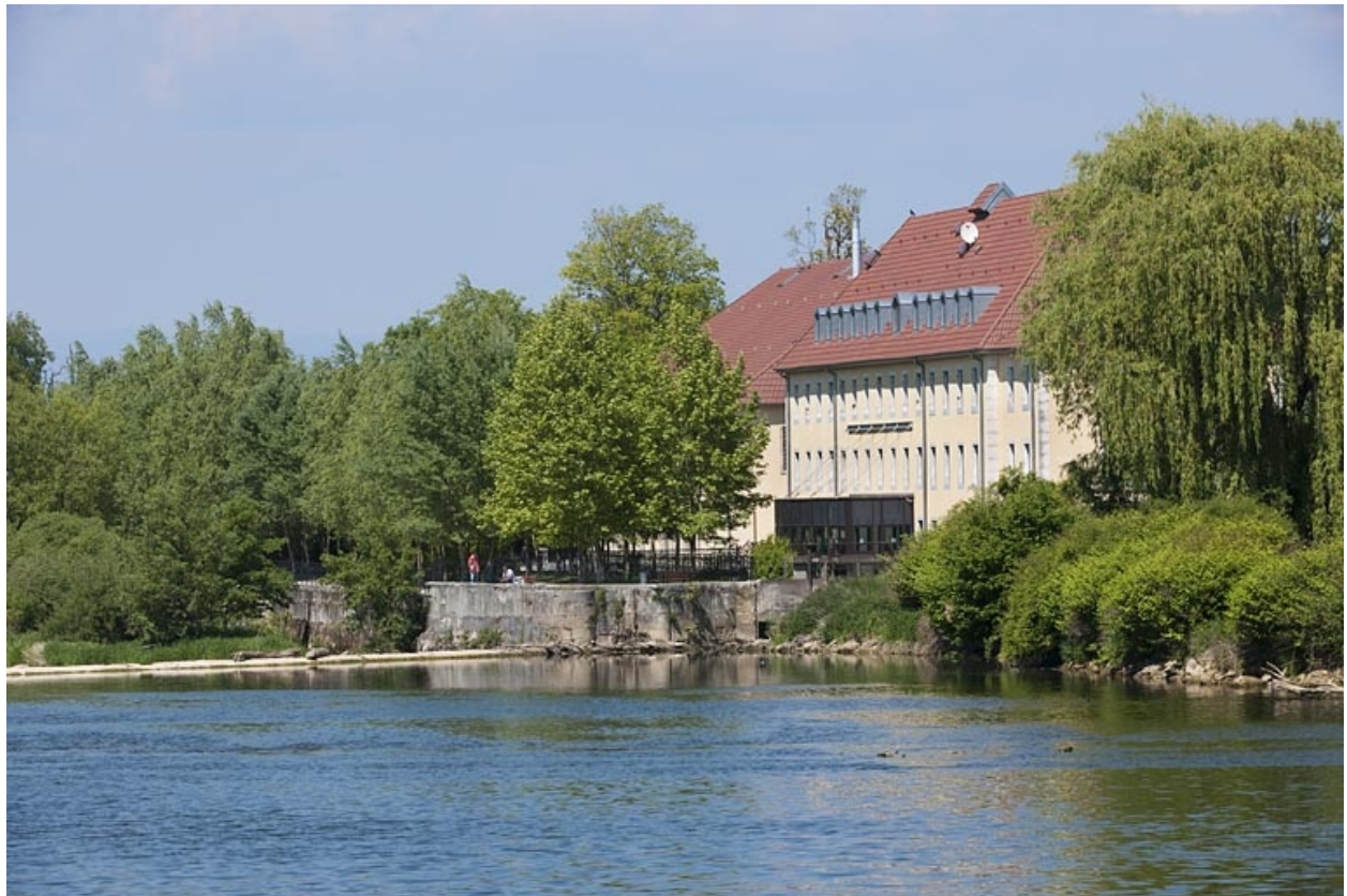
Vue d'ensemble depuis l'amont.
