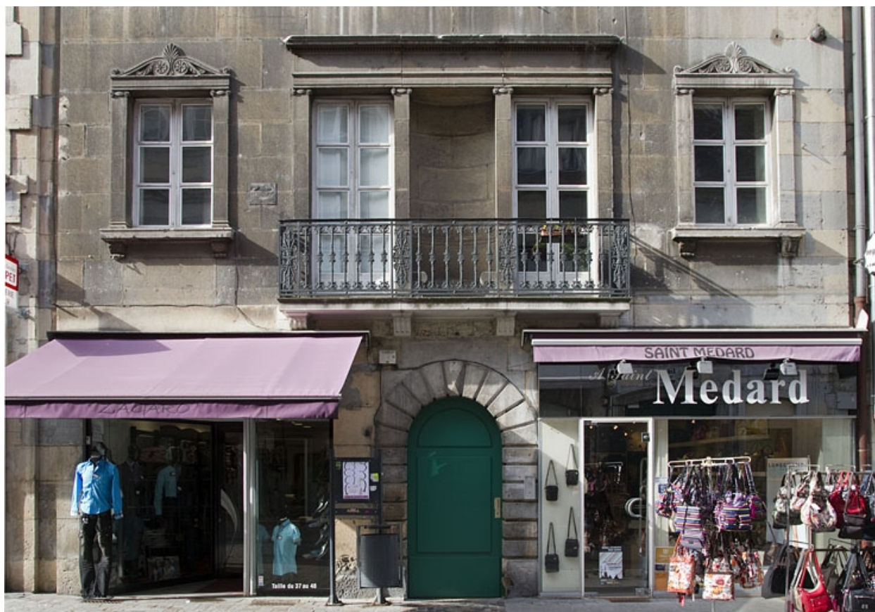
Logis principal : détail du rez-de-chaussée sur rue.
