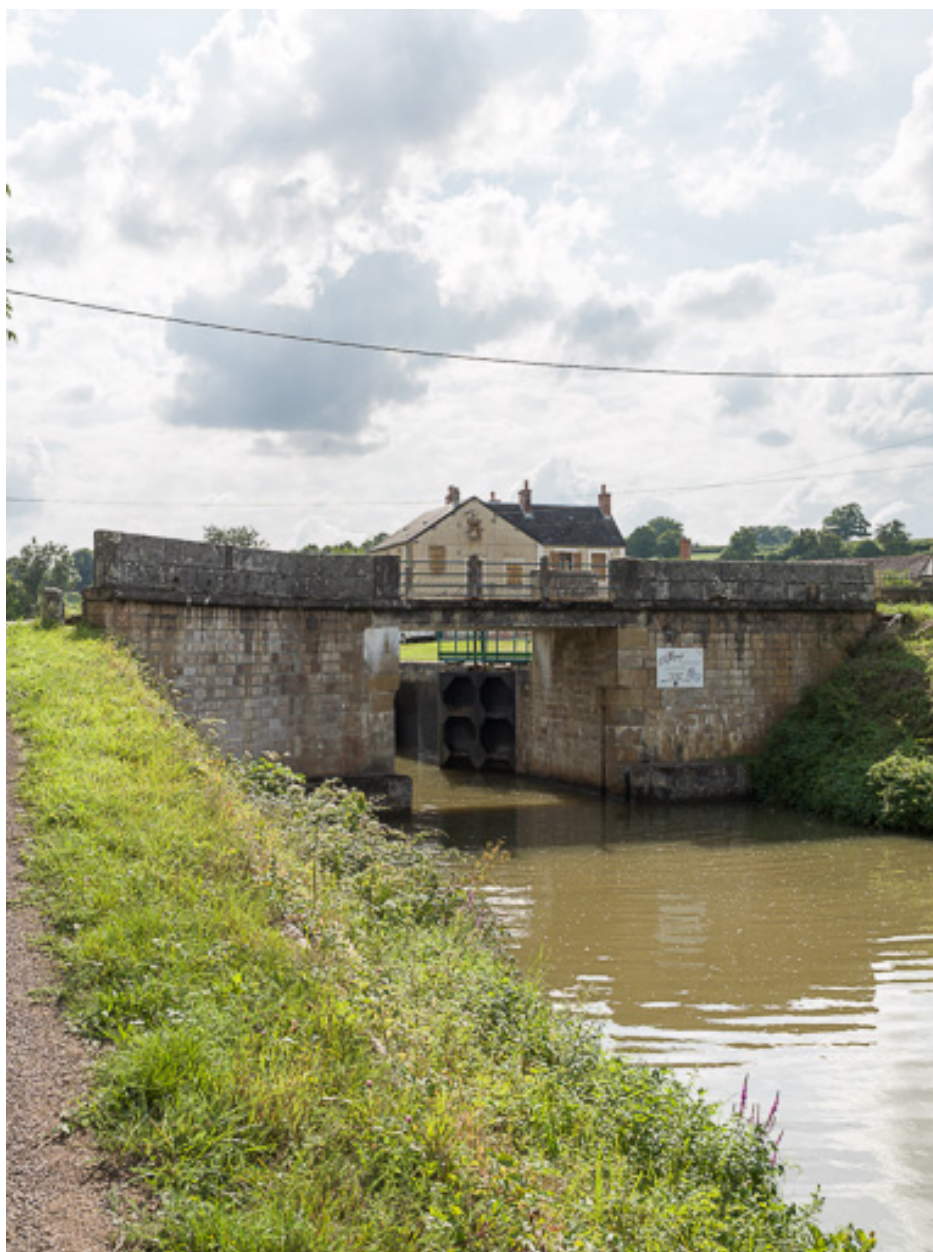
Vue d'ensemble du pont.
